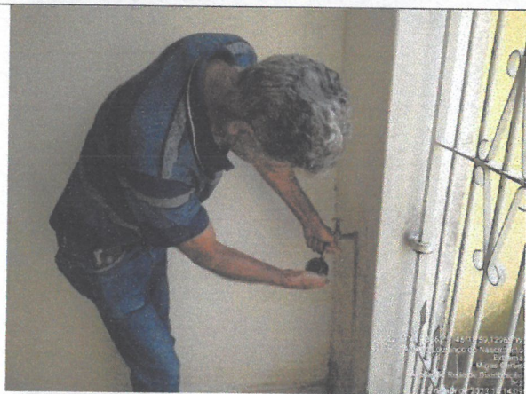
Figura3—Verificação da pressão de água na residência.
