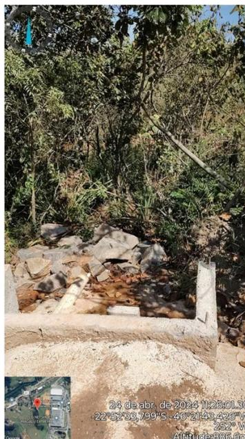
**Figura 11.** Saída de drenagem na APP do lago (pós extravasor)
