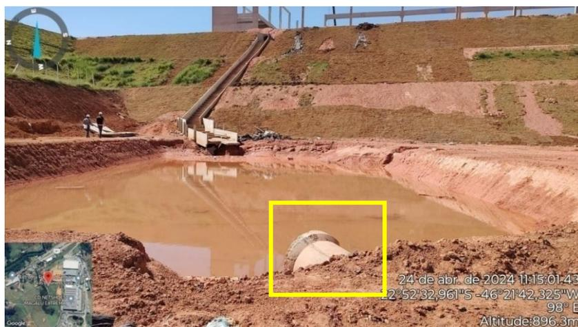
**Figura 9.** Tanque de retardo de águas pluviais em execução/operação. Destaque para extravasor (só em necessidade) para lago local (montante do lançamento principal).
