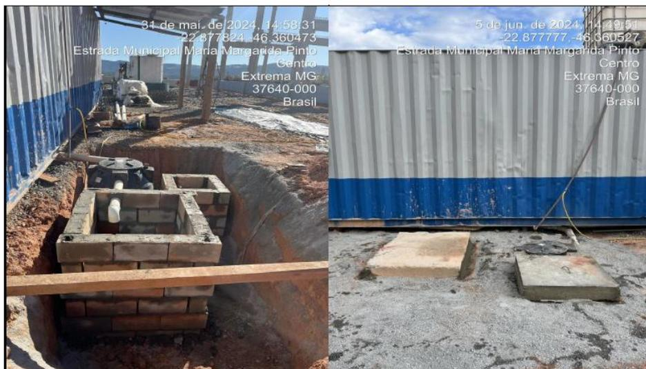
Figura 5. Biodigester instalado para atendimento ao canteiro de obras.
