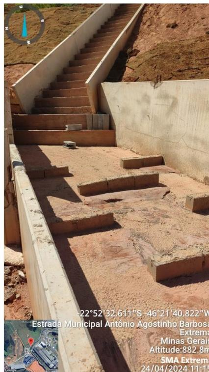
**Figura 16.** Detalhe dos redutores de velocidade para lançamento no tanque de retardo. Sugere-se aumentar rugosidade para reduzir velocidade deste dissipador
