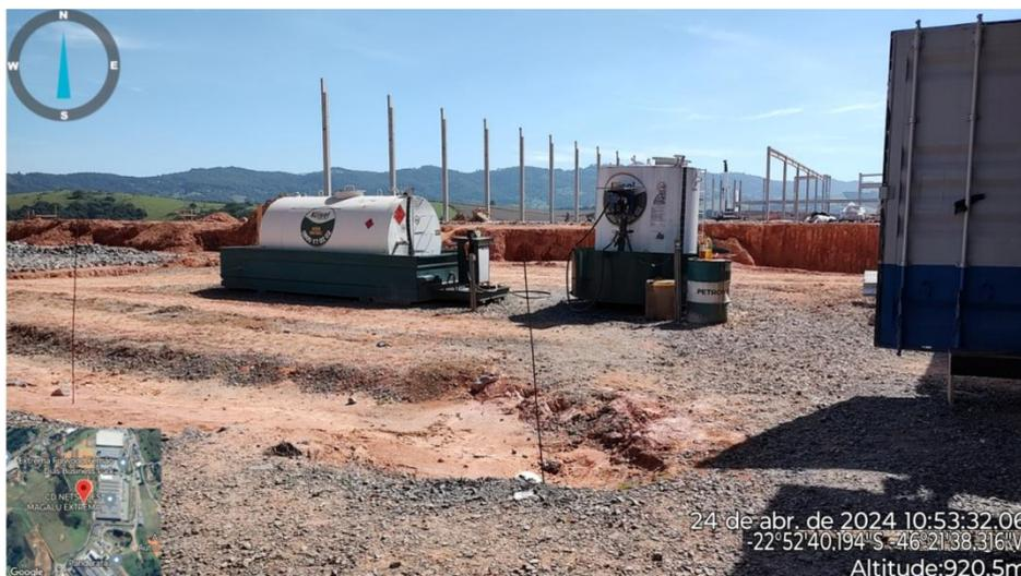
Figura 18. Tanques de armazenamento de combustíveis.
