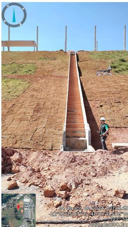
**Figura 15.** Escada hidráulica
