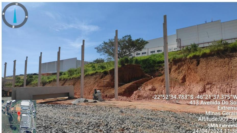
Figura 6. Área onde ocorreu rompimento do tanque de retardo de drenagem de águas pluviais do terreno vizinho devido obras de terraplanagem deste empreendimento, sendo corrigido para lançamento da drenagem conjunta (BRL Trust+Pré-vaie)
