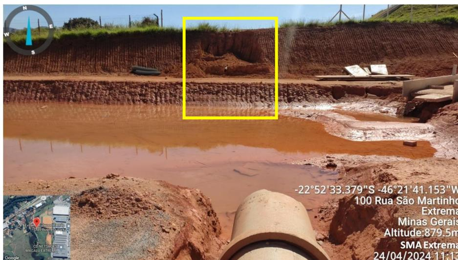
**Figura 7.** Lateral do tanque de retardo, onde se propõe fazer principal saída do lançamento da drenagem de águas pluviais
