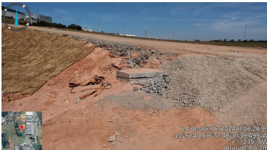
**Figura 13.** Rampa de acesso da estrada ao galpão, com destaque para poço de visita do sistema de drenagem.
