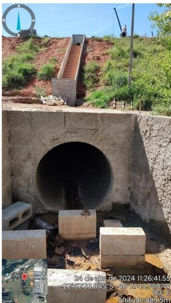
**Figura 10.** Escada hidráulica de lançamento final do extravasor do tanque de retardo de drenagem
