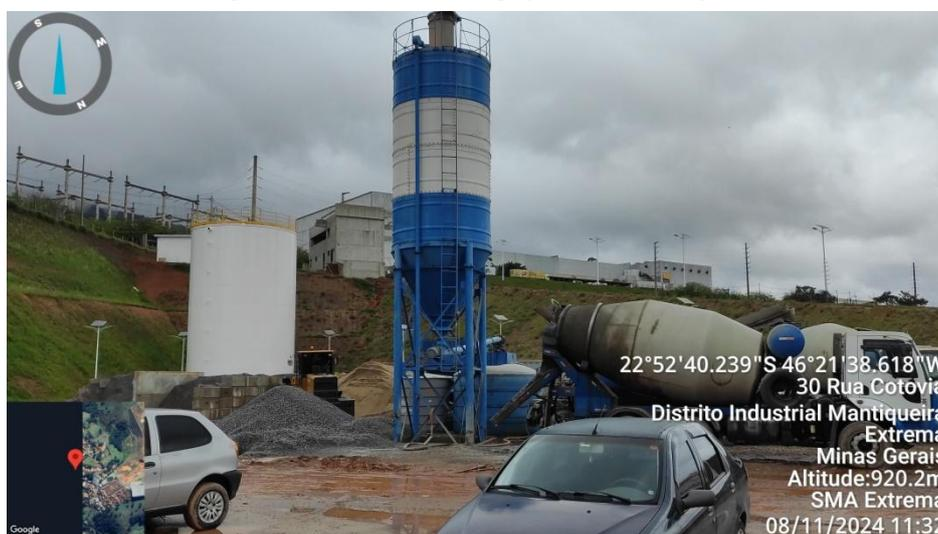
Figura 3. Usina de concreto instalada para suporte a construção.
