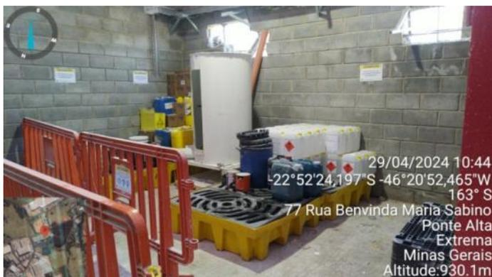
Figura 11. Área de armazenamento de produtos químicos (inadequado).
