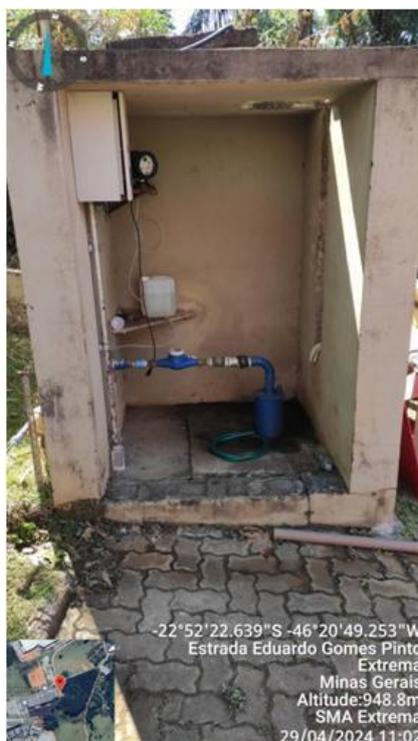
Figura 21. Poço tubular de captação de águas subterrâneas.
