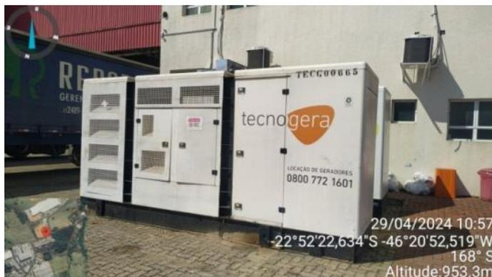
Figura 18. Geradores de energia à diesel.
