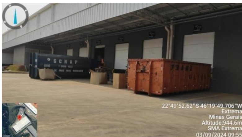
Figura 11. Contêineres de coleta de resíduos recicláveis.
