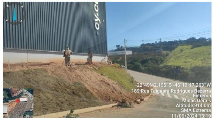
Figura 52. Talude com solo exposto lado sul do G200.
