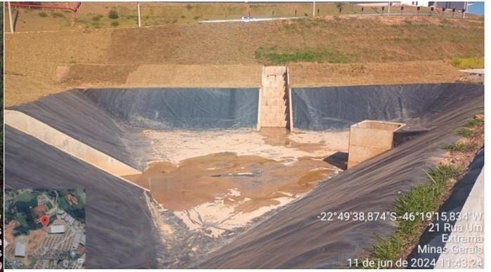
Figura 50. Tanque de retardo de águas pluviais (G300/G200).
