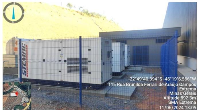
Figura 46. Geradores e tanque de combustível aos fundos do G300.
