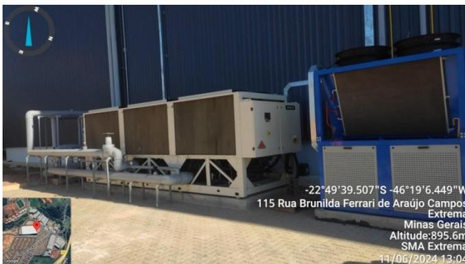
Figura 45. Sistema de refrigeração Chiller (G300).
