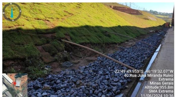
Figura 48. Sistema de drenagem, lateral oeste do Galpão 100
