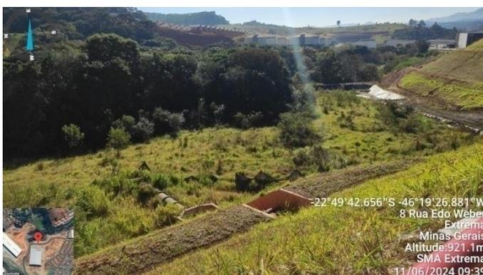
Figura 47. Escada hidráulica e tanque de retardo do sistema de drenagem pluvial (G100/G200).
