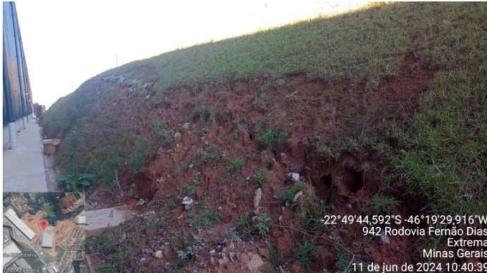
Figura 49. Talude sem vegetação, lado oeste do G100.
