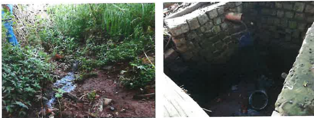
Figura 94 – Lançamento atrás do Auto Posto da Gruta II e lançamento atrás do Auto Posto da Gruta II.
