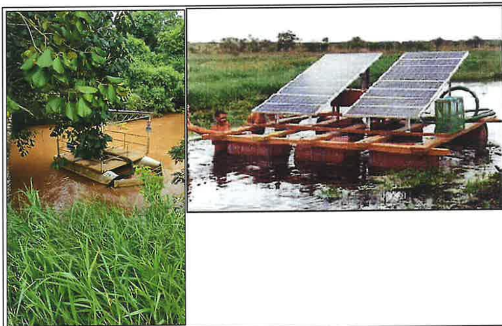
Figura 173 - Captação Camanducaia – Flutuante para colocação das placas
