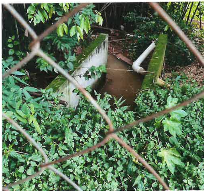
Figura 139 - ETE Pérola (Corpo Receptor)
