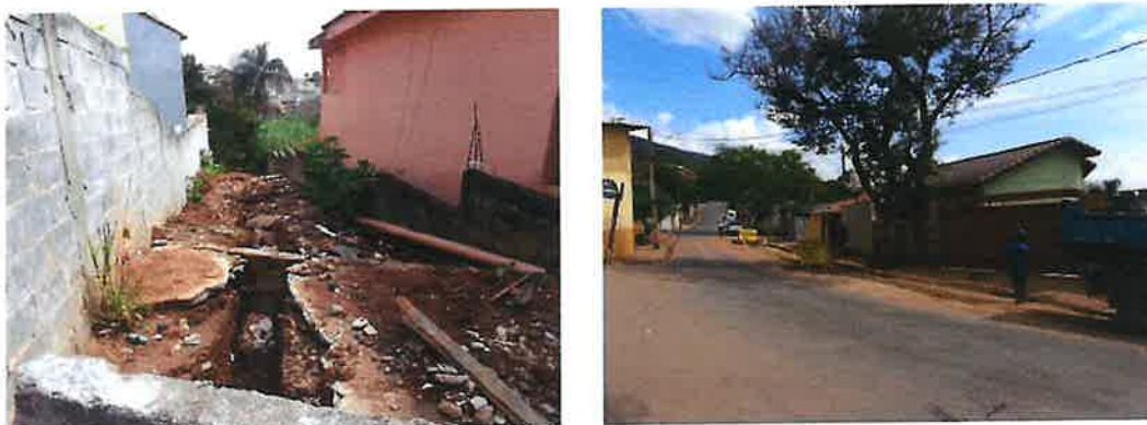
Figura 96 – Faixa de servidão e Obras na rua Mônaco.
