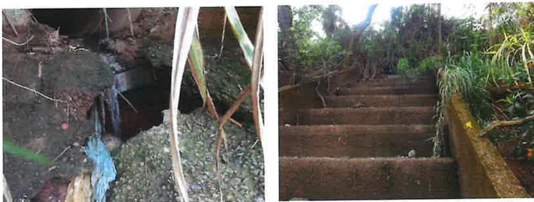
Figura 90 – Buraco na escada hidráulica permitindo com que o efluente infiltre pela estrutura e escada hidráulica por onde deveria passar o efluente.
