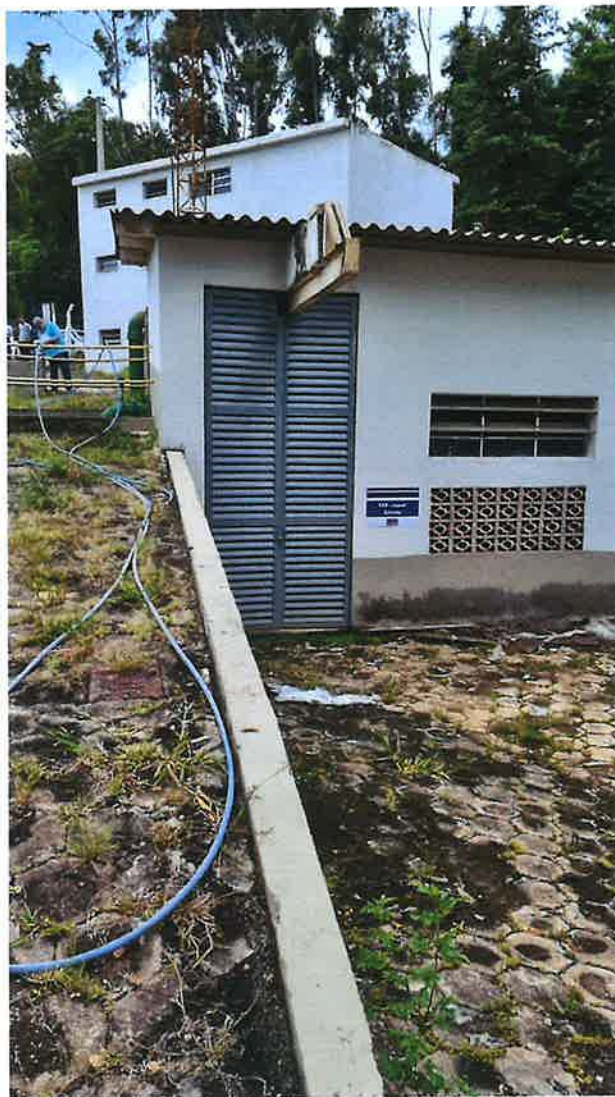
Figura 15 - EAB Jaguari – Estrutura civil
