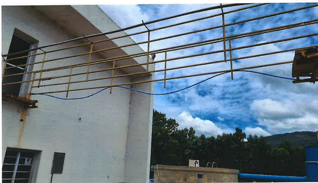
Figura 53 - Passarela ETA Jaguari
