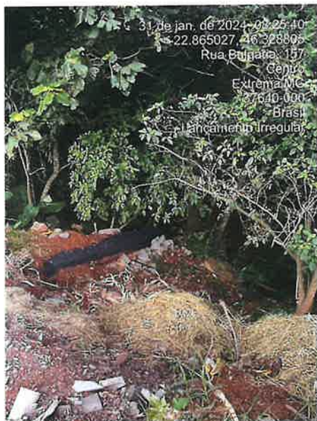
Figura 100 - Lançamento Irregular - Rua Bulgária
