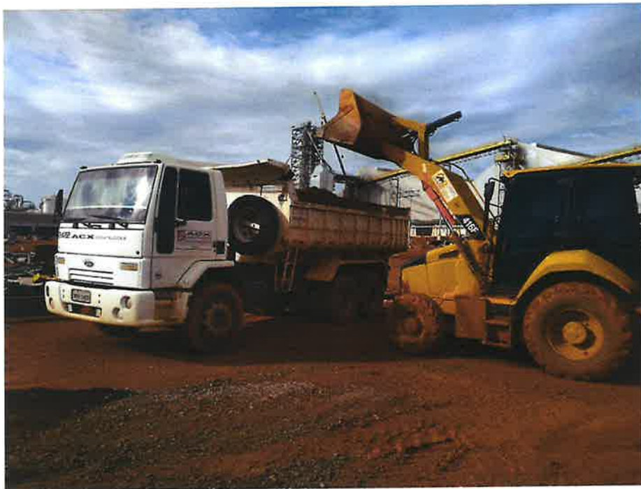
Figura 181 – Retroescavadeira e Caçamba.
