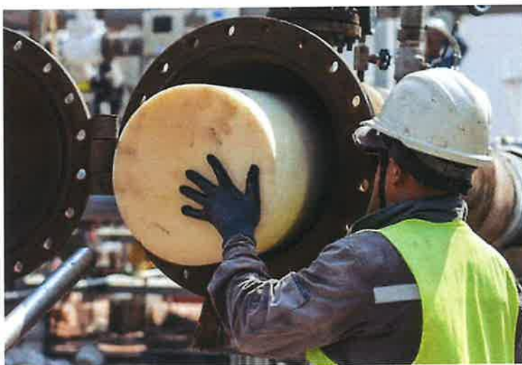
Figura 184 - Inserção do PIG na Tubulação para Manutenção Preventiva.
