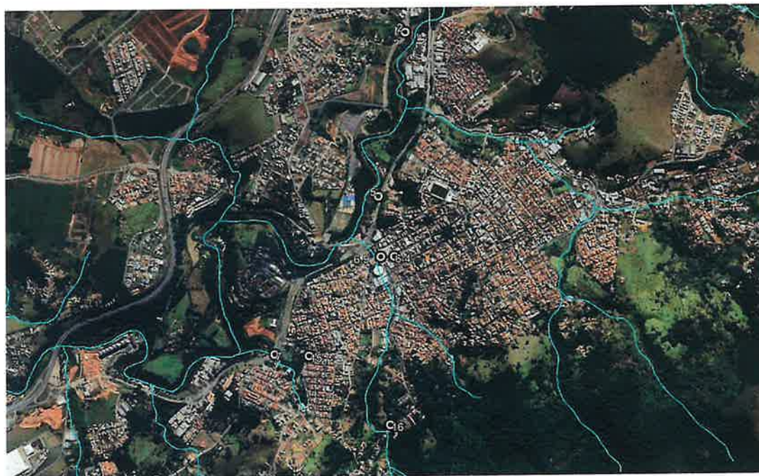
Figura 86 – Pontos de lançamento irregulares – Ausência de rede ou estação elevatória – Parte 2.
