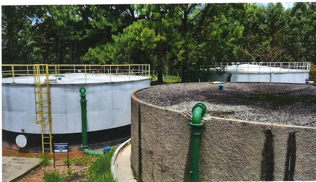
Figura 62 - RAP 01, RAP 02 e RAP 03 (Área ETA Jaguari)
