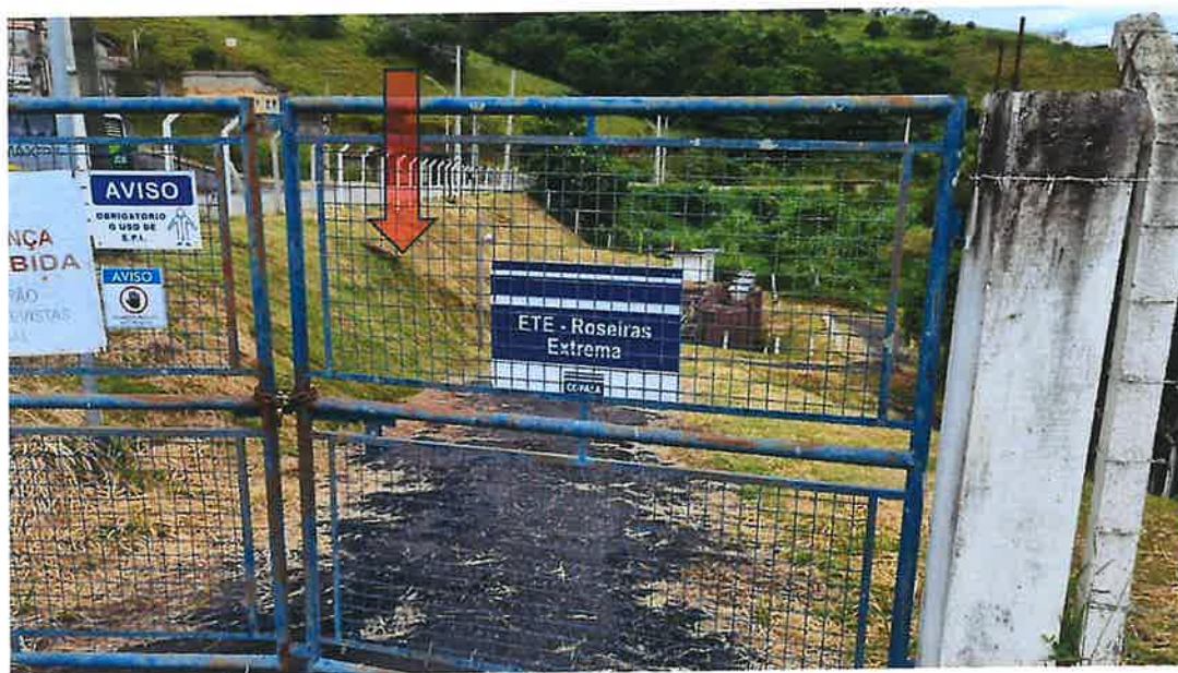
Figura 170 - ETE Roseira - Local para colocação das placas solares
