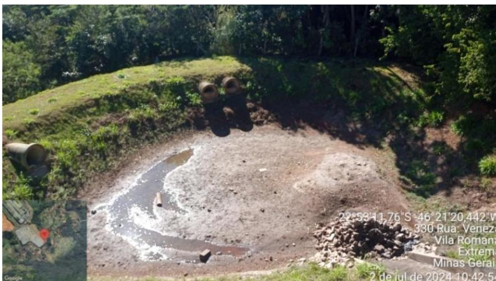
**Figura 15.** Tanque de retardo de águas pluviais.
