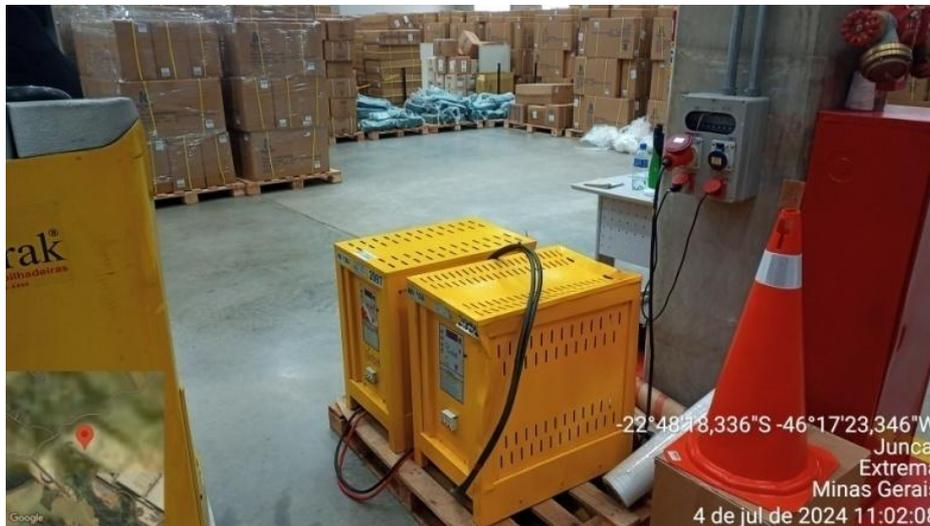
**Figura 8.** Área de recarga de baterias de empilhadeiras elétricas.
