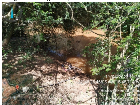
Figura 11. Bombeamento de água do Rio Camanducaia para testes de perfuração na região da ponte
