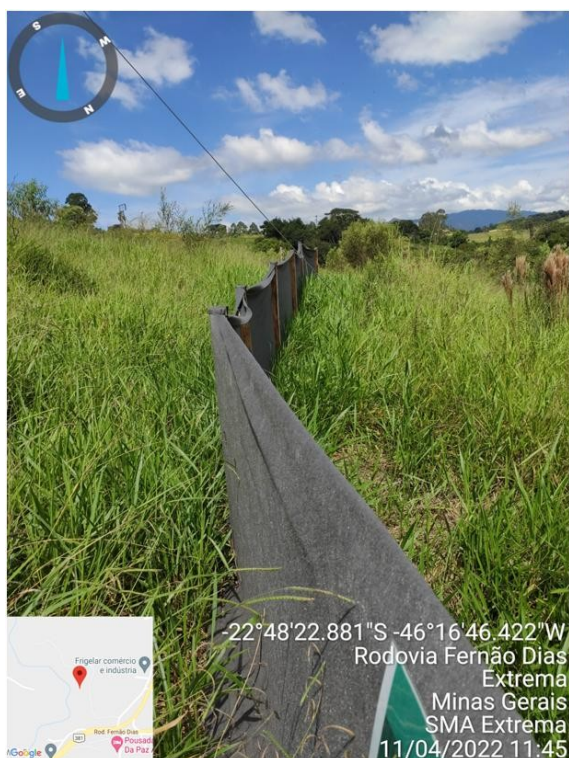
Figura 21. Manta geotêxtil próxima da área onde será implantada lançamento de drenagem do tanque 2
