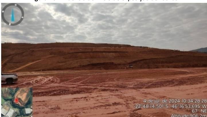
Figura 27. Vista do centro sul do empreendimento
