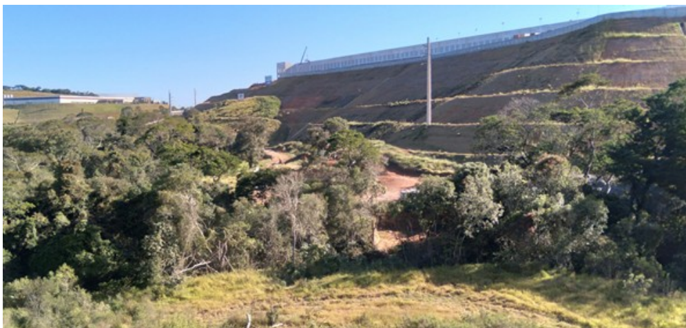
Figura 14. Área onde será implantada a ponte sobre o Rio Camanducaia
