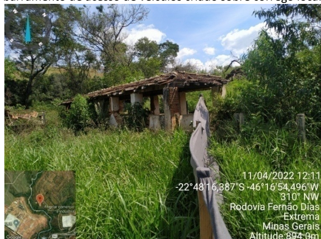
Figura 10. Construções a serem demolidas no terreno
