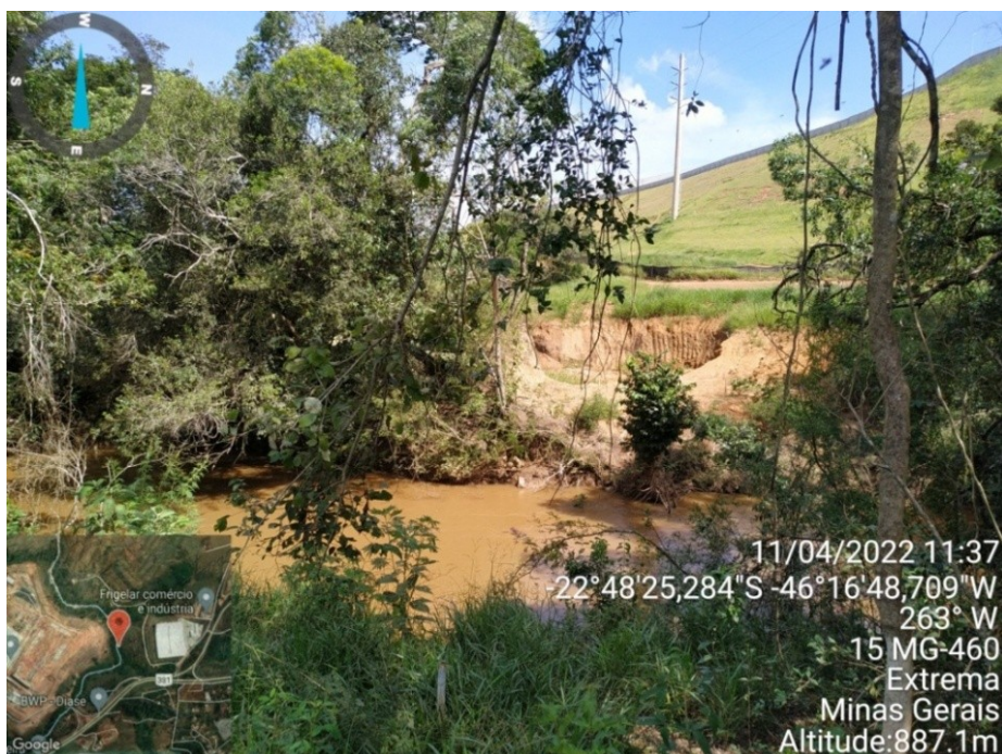
Figura 13. Área escavada na APP para implantação dos pilares de sustentação da ponte. Fonte: SMA
