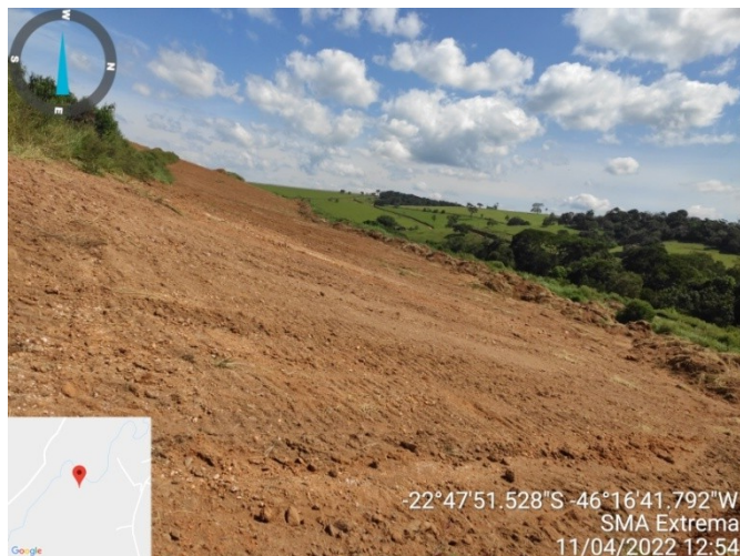
Figura 2. Vista Oeste da área do empreendimento, com remoção de camada vegetal
