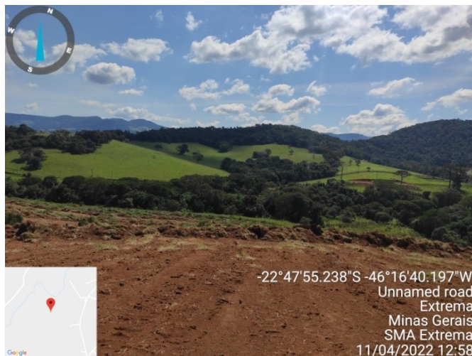
Figura 1. Vista da face Noroeste do terreno, com remoção da camada vegetal
