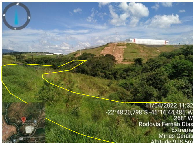
Figura 4. Vista da face Sul do terreno, e área da do acesso e criação da ponte sobre o rio Camanducaia
