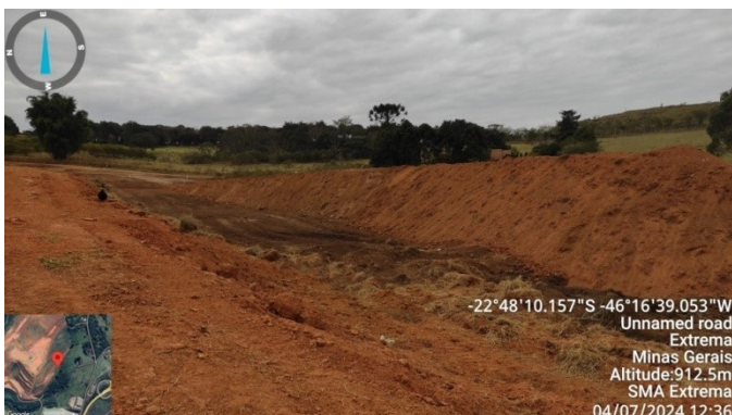
Figura 22. Disposição de solo rico em matéria orgânica e local do futuro canteiro de obras
