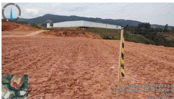
Figura 20. Marcação da perfuração de poço tubular subterrâneo outorgado pelo IGAM (Portaria 2009473/2022)
