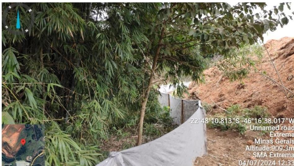
**Figura 08.** Manta geotêxtil ao redor da APP da nascente.
