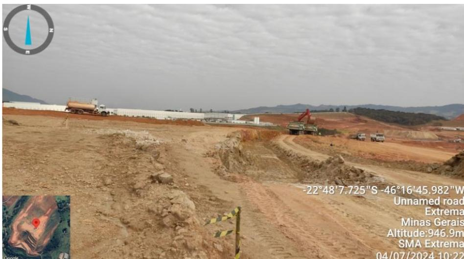
**Figura 03.** Face Oeste do terreno em execução de terraplanagem e rebaixamento para atingir cota de rocha.
