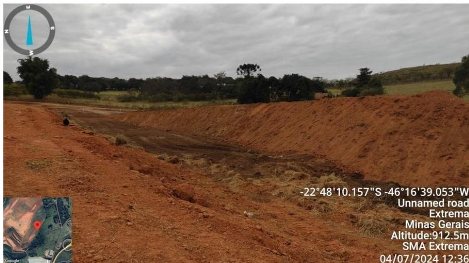
**Figura 06.** Disposição de solo rico em matéria orgânica e local do futuro canteiro de obras.
