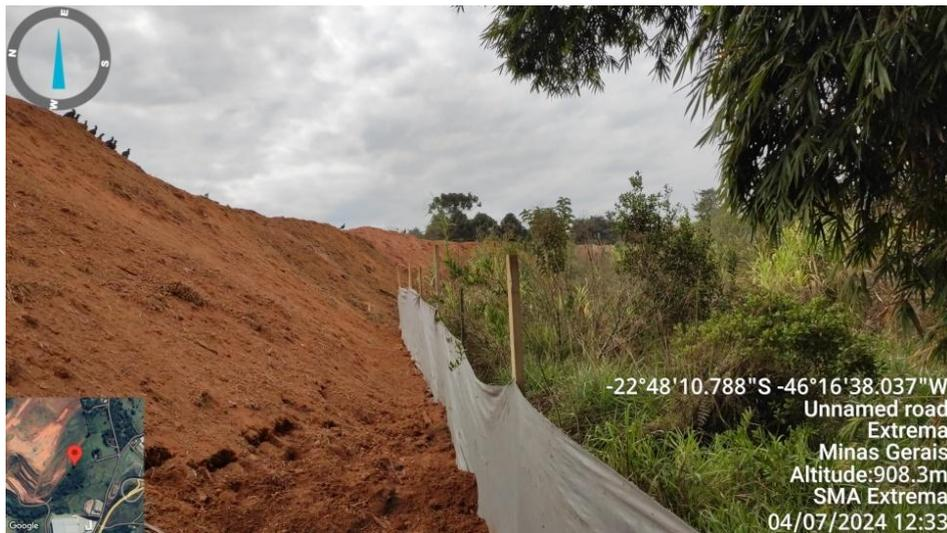
**Figura 07.** Solo disposto nas margens da delimitação com a APP da nascente. Notificação para reforçar estruturas de contenção de solos e carreamento de partículas finas (microgranulometria).
