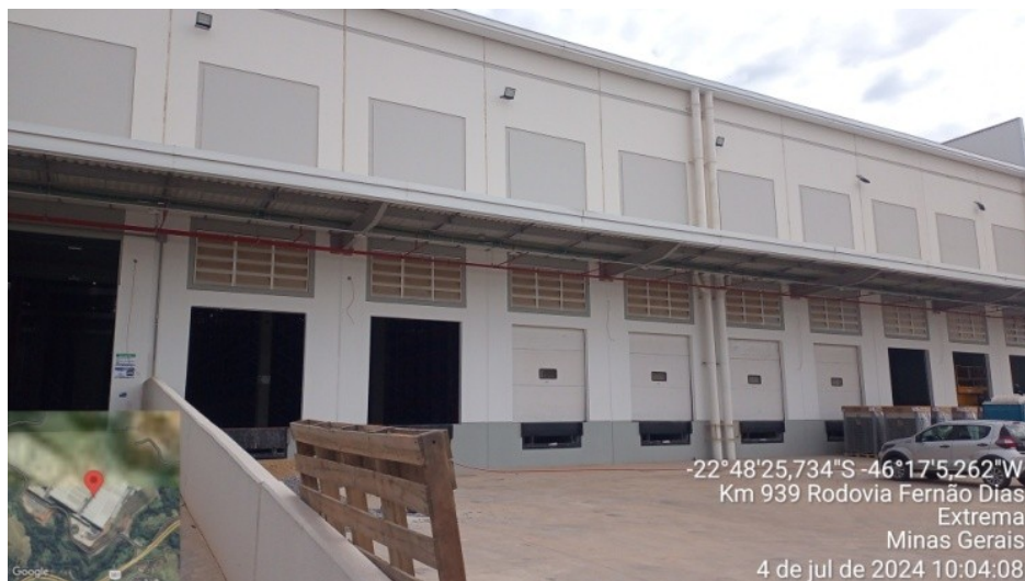
Figura 01. Vista frontal do empreendimento.
