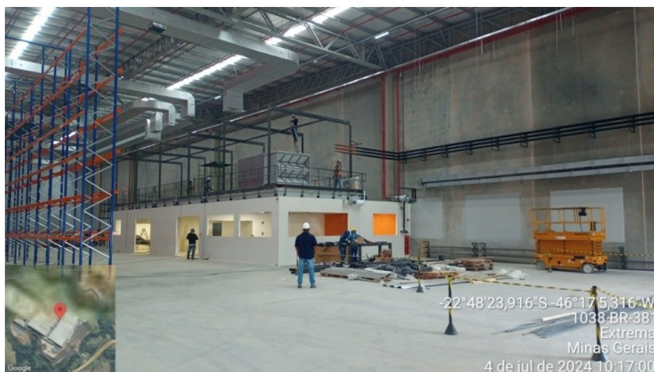
Figura 05. Mezanino para instalação do sistema de resfriamento.
