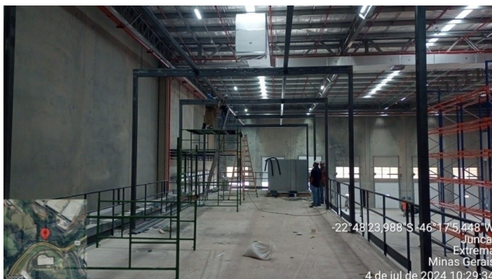
Figura 06. Mezanino para instalação do sistema de resfriamento
