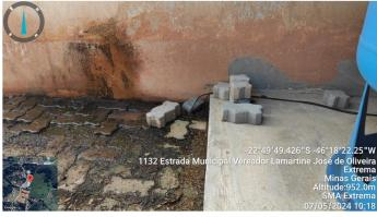
Figura 20. Lançamento irregular de água do compressor.
