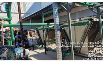
**Figura 17.** Sistema de resfriamento geral de água em circuito fechado.
