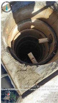
Figura 25. Sumidouro recebendo lançamento dos dois sistemas.
