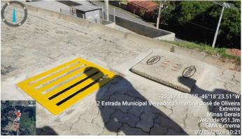
Figura 21. Acesso a rede de lançamento de águas pluviais
