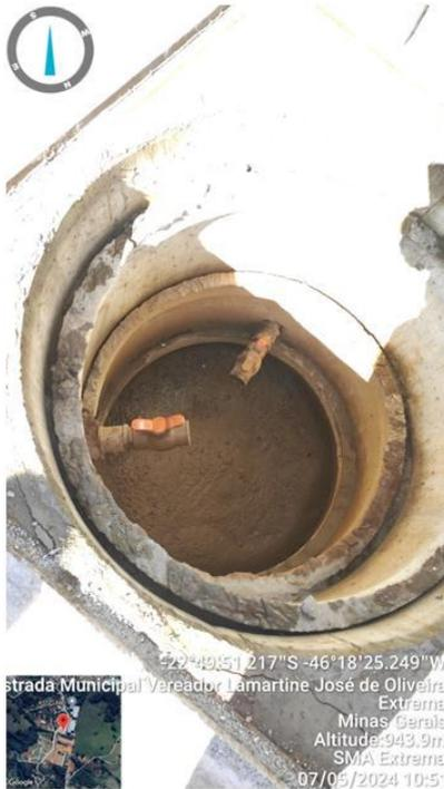
Figura 24. Tanque de limpeza de lodo do sistema 2.
