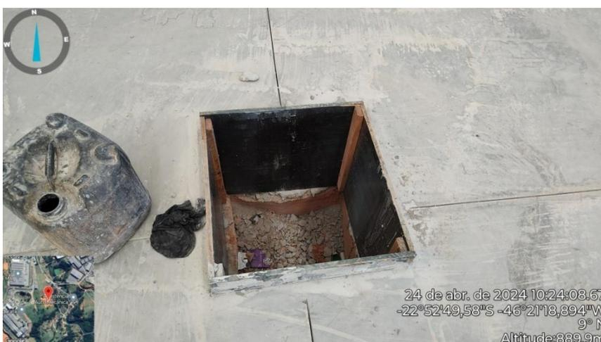
Figura 13. Ponto de acesso para tubulação de sanitários na região central do galpão
