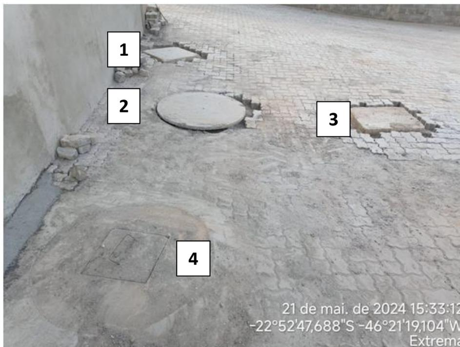
Figura 26. Sistema de tratamento de efluente da face norte do galpão desobstruídas, , destaque para as tampas em concreto que fazem o acesso para cada fase e sistema (01 – Caixa de passagem, 02 – Biodigestor, 03 – Caixa de leito de seca do lodo e 04 – Sumidouro).
