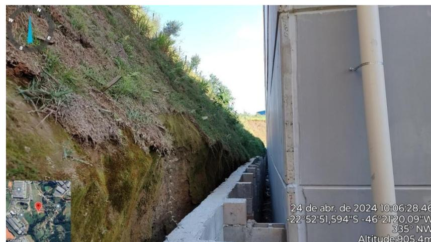
Figura 3. Muro de arrimo construído aos fundos do terreno
