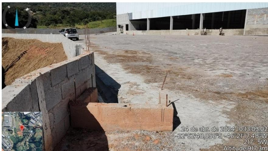
Figura 19. Tanque de retardo de águas pluviais - Central
