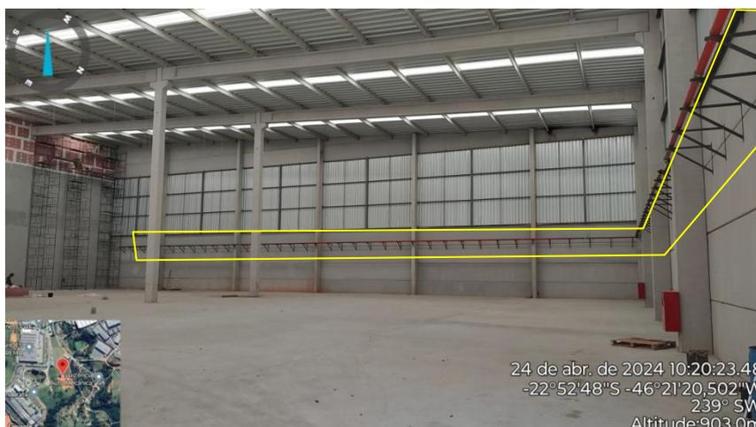
Figura 12. Área interna Sul do galpão. Destaque tubulação de prevenção de incêndios em execução
