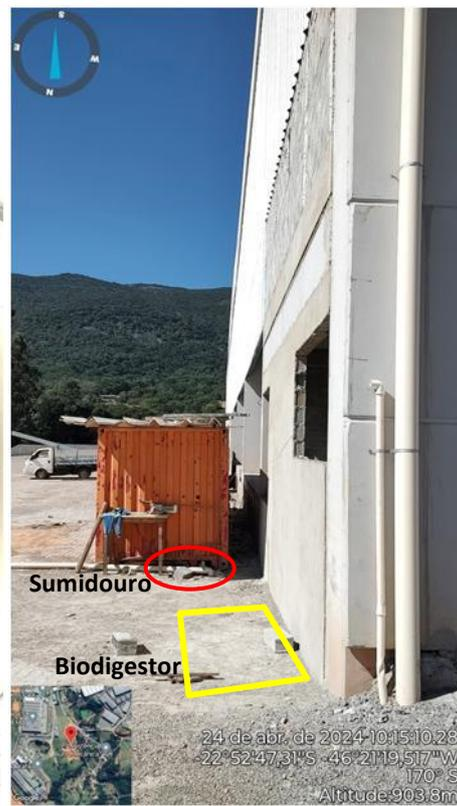
**Figura 16. Sistema de tratamento de esgoto do Norte do galpão. Acesso ao biodigestor e sumidouro obstruído**
