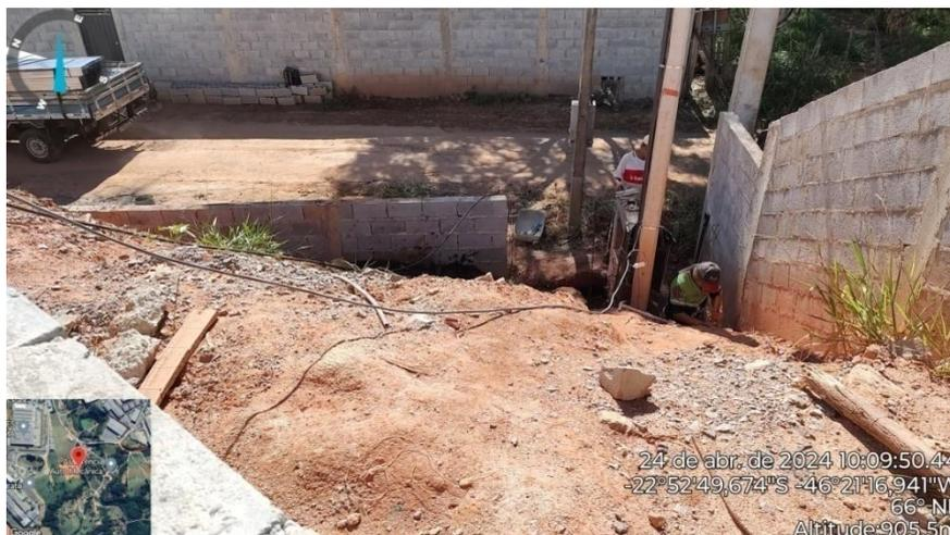
Figura 8. Finalização das adequações e acesso aos relógios de energia elétrica e abastecimento de água potável.
