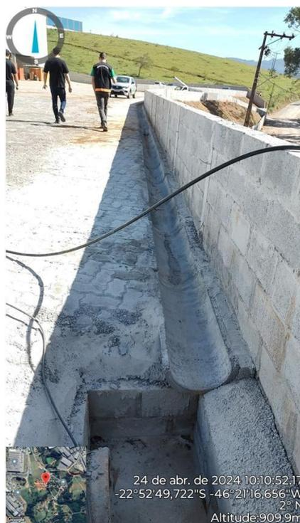
Figura 22. Canaletas de drenagem do pátio
