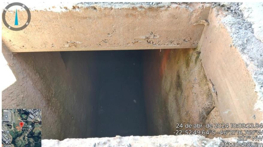
Figura 18. Visualização das dimensões internas do tanque de retardo (Fig 17)
