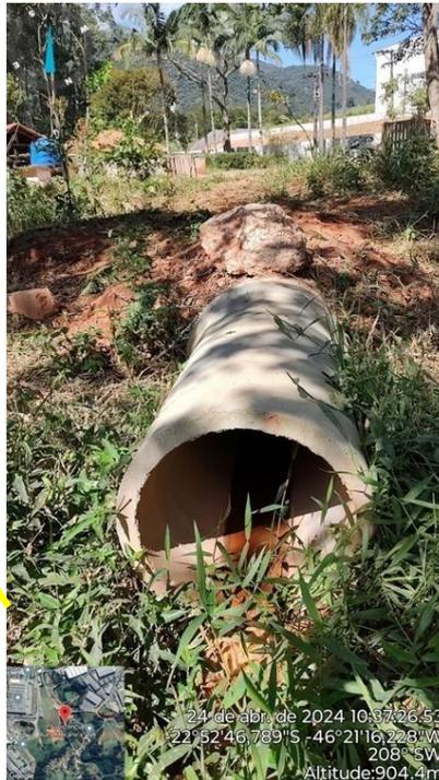
**Figura 3 B. Fim da tubulação de drenagem dentro da APP e no terreno de terceiro.**
