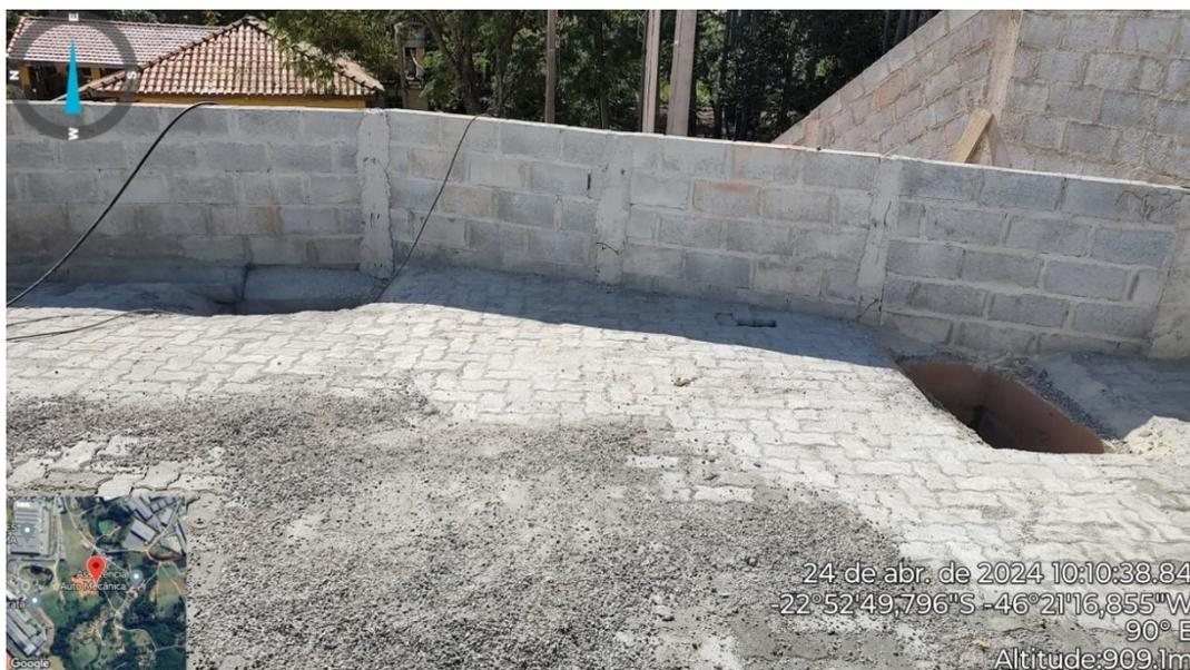
**Figura 17. Tanque de retardo de águas pluviais – Face Sul**
