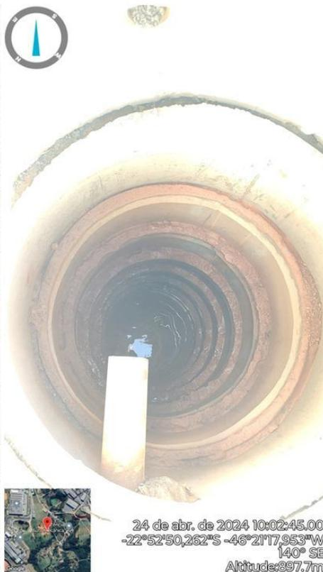
**Figura 15. Sumidouro do Biodigestor na Face Sul**
