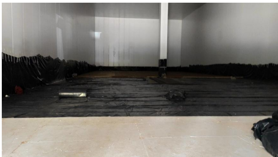
Figura 3. Área de Armazenamento 2 em processo de finalização do piso.
