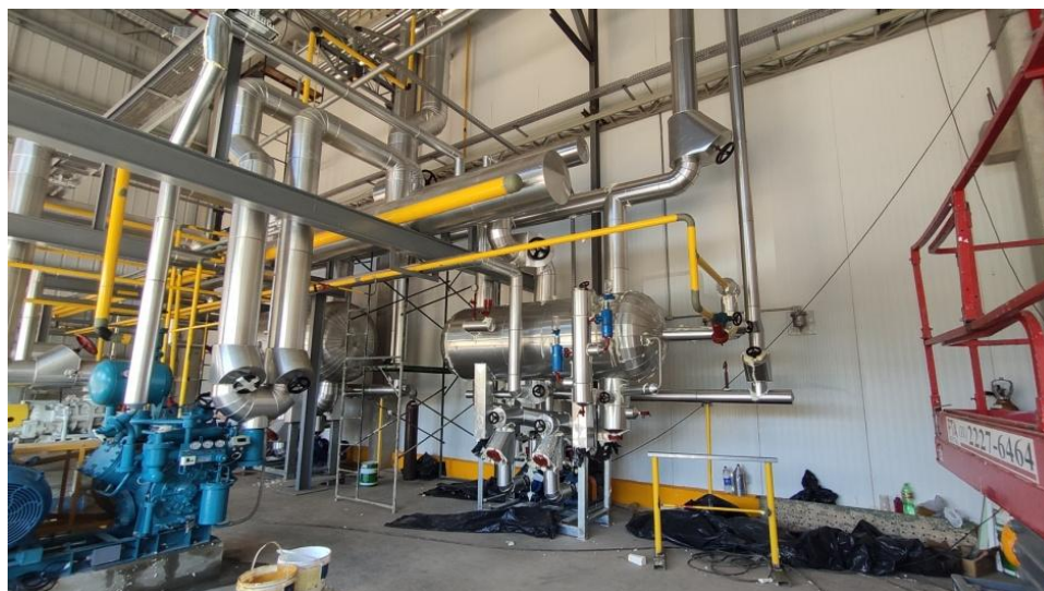
Figura 13. Sala de máquinas do sistema de resfriamento em instalação.
