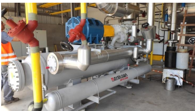
Figura 14. Compressor utilizado para resfriamento.
