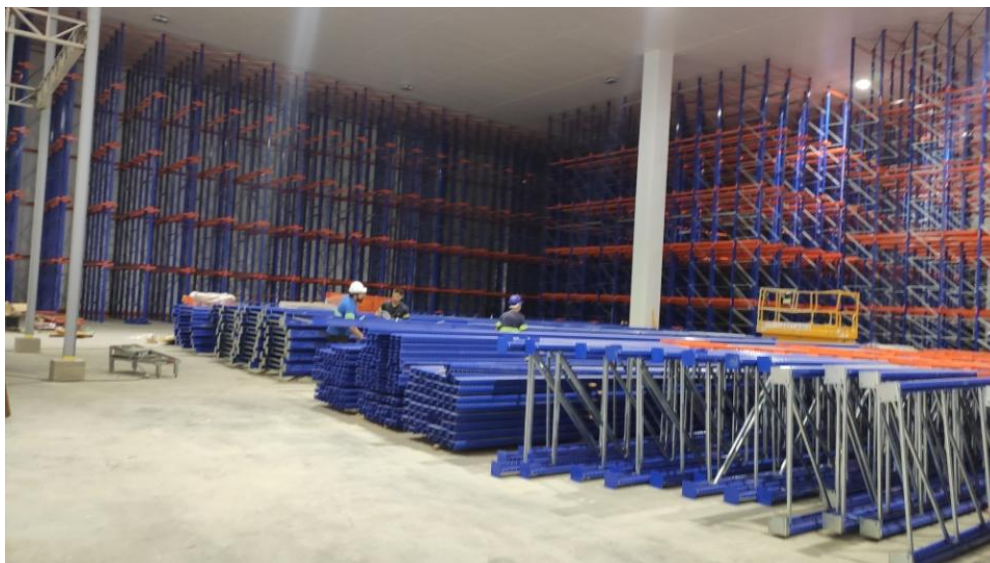
Figura 4. Área de Armazenamento 1, em processo de instalação das estruturas porta paletes.
