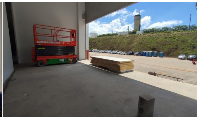
Figura 12. Sala de recarga de baterias em execução.
