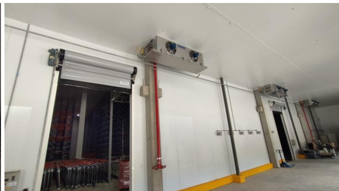
Figura 10. Sistema de resfriamento da área de transição (entre docas e módulos).
