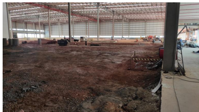
Figura 6. Área de Armazenamento 3, em processo de instalação do piso.
