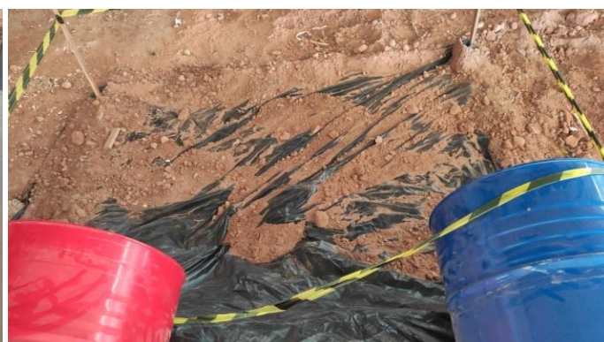
Figura 8. Área de Armazenamento 3, material sem devida contenção do polipropileno
