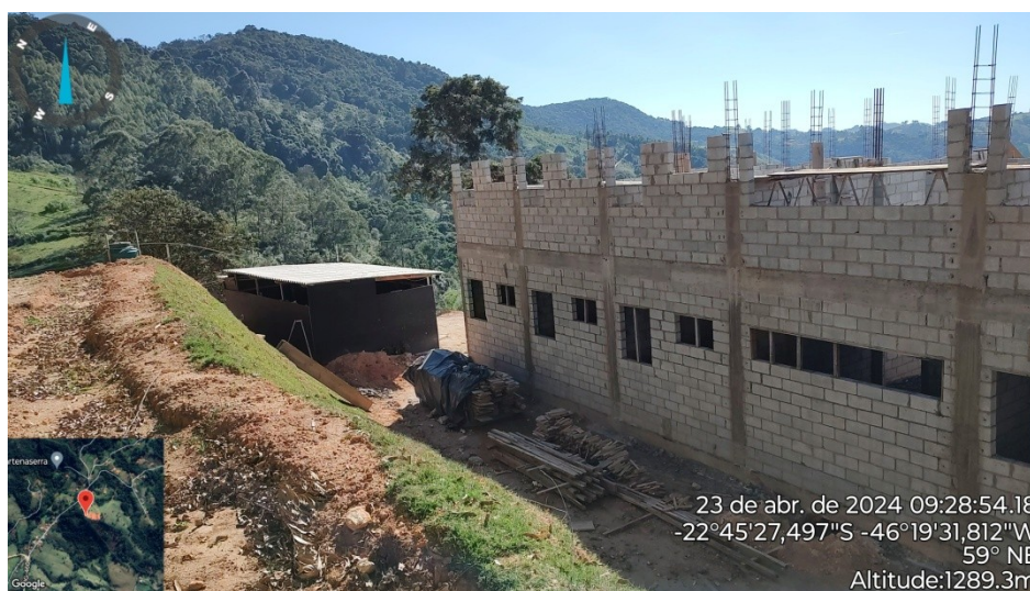
Figura 2. Bloco 01 em fase de construção, sem alvará.
