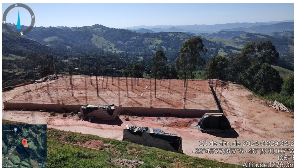
Figura 3. Bloco 02 em fase de construção, sem alvará.
