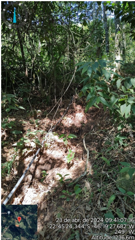
Figura 9. Carreamento de terra para APP.
