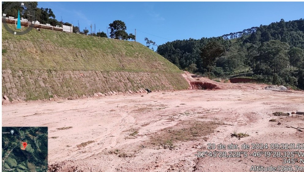
Figura 4. Platô para construção do Bloco 03.
