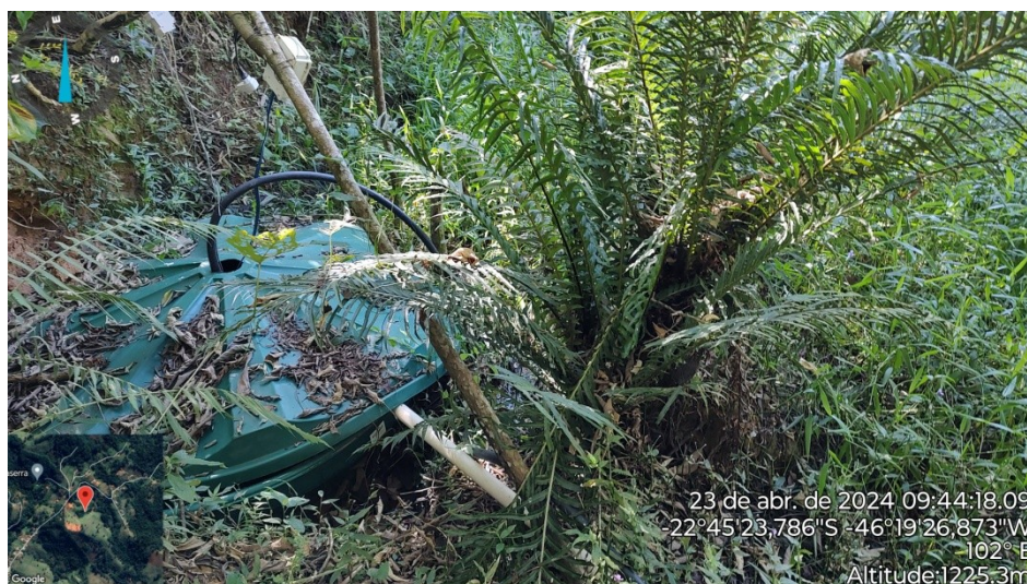
Figura 12. Captação de água da nascente.
