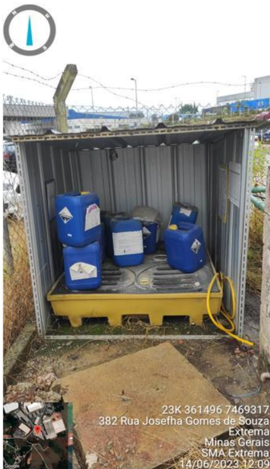
Figura 25. Armazenamento de cloro para inserção na água captada
