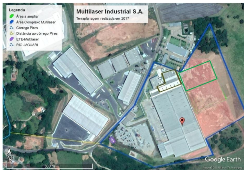
Figura 9. Terreno depois da realização da terraplanagem na área. Fonte: Google Earth Pro (nov/2017)
