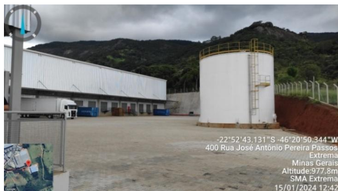
Figura 33. Vista frontal G10 com talude frontal sem finalizar cobertura vegetal.
