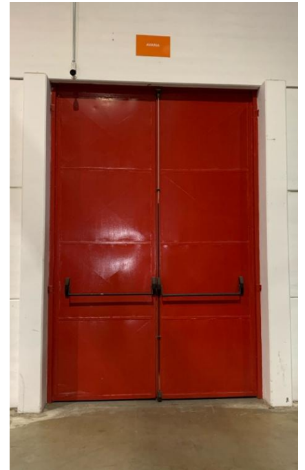
Figura 9. Área de armazenamento de produtos com avarias
