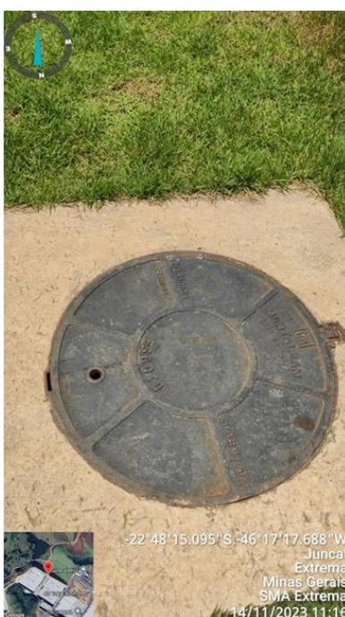
**Figura 14.** Tampa de acesso ao poço de bombeamento da estação elevatória de esgoto.
