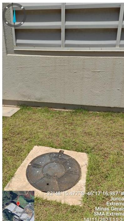
Figura 9. Tanque de contenção em caso de vazamentos na área de recarga de baterias.
