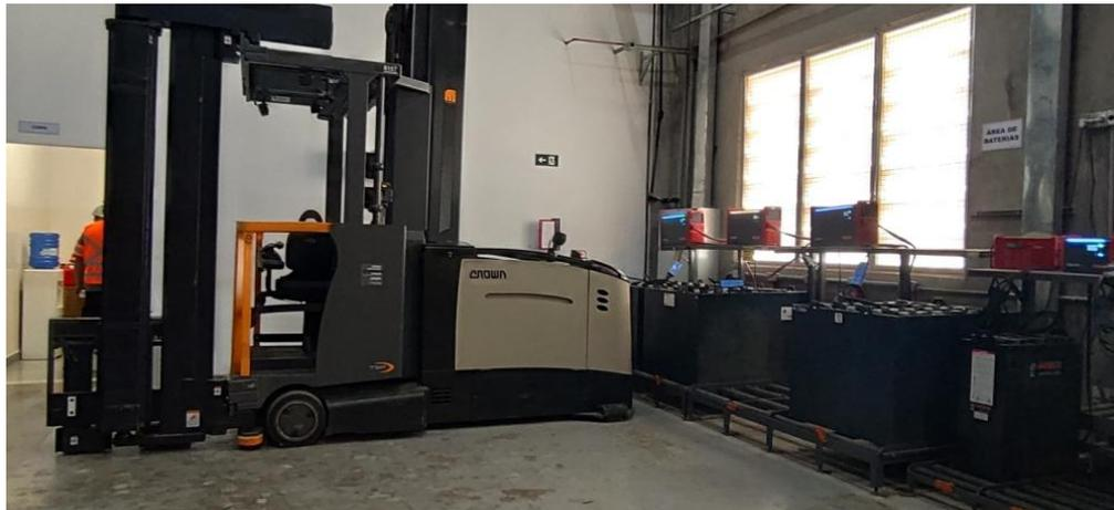
Figura 7. Área de recarga de baterias de empilhadeiras elétricas.
