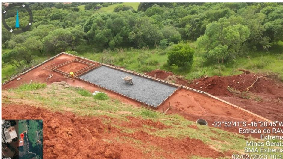
**Figura 7.** Área de instalação da Estação de Tratamento de Efluentes – ETE e sumidouros.
