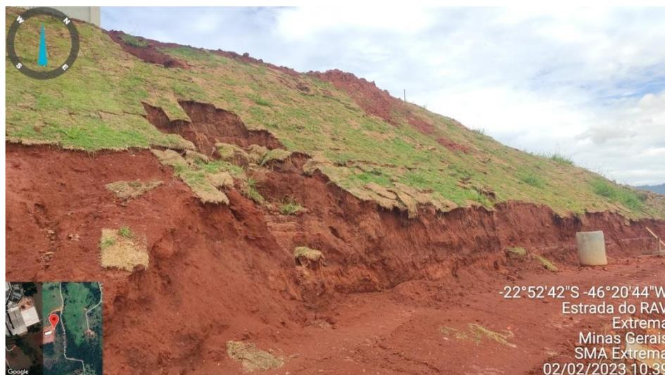
**Figura 12.** Talude em fase de cobertura vegetal.
