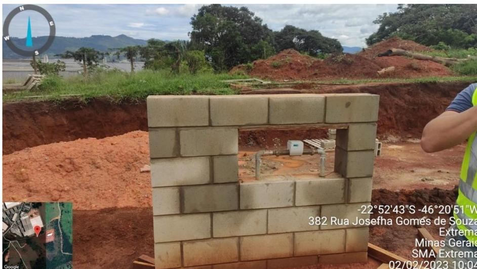
**Figura 8.** Evidência de ligação à rede de abastecimento de água potável da concessionária local.
