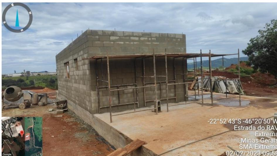
**Figura 10.** Guarita em construção sobre o tanque de retardo de águas pluviais.
