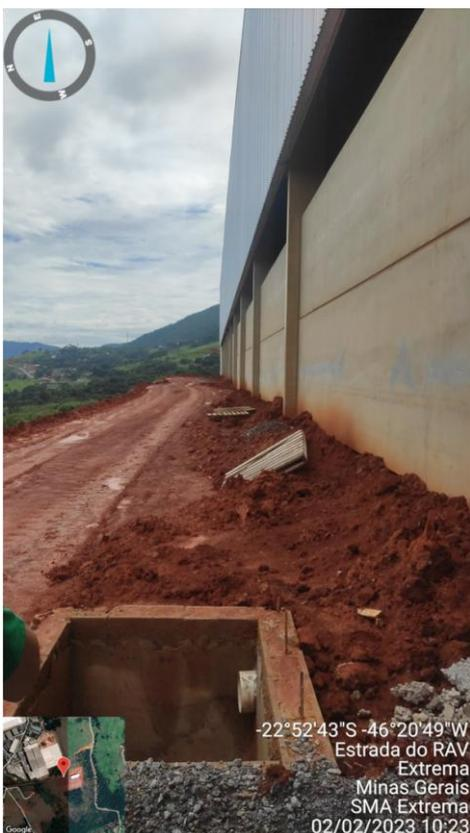
**Figura 13.** Instalação de caixa de passagem para drenagem de águas pluviais.
