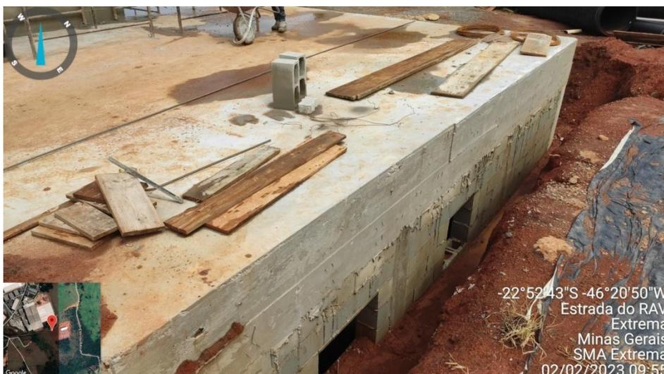
**Figura 9.** Tanque de retardo de águas pluviais em construção na porção noroeste do terreno.
