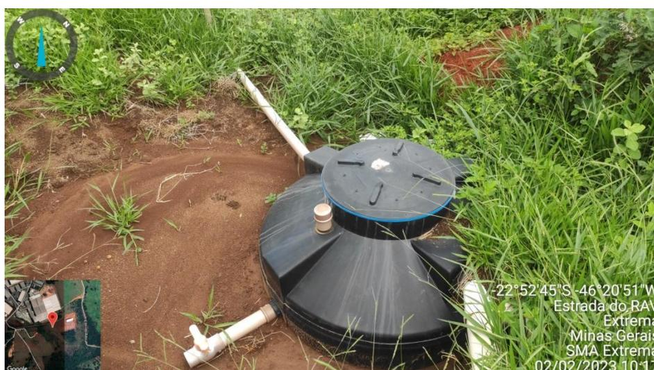
**Figura 6.** Biodigestor instalado para atendimento ao canteiro de obras.
