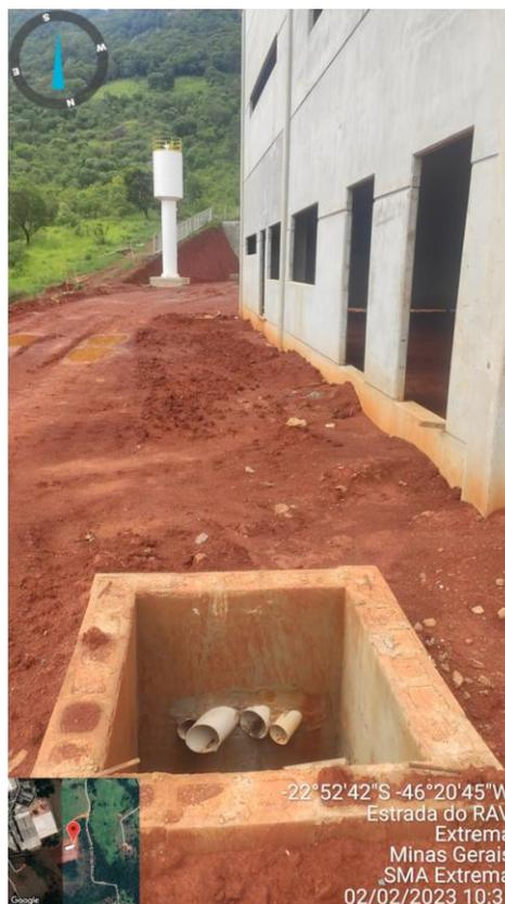
**Figura 14.** Instalação de caixa de passagem para drenagem de águas pluviais.
