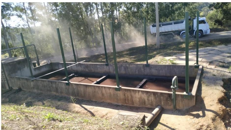
**Figura 12.** Tanque de recirculação de água do sistema de resfriamento.
