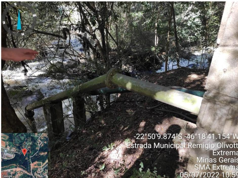
Figura 14. Captação de água no Rio Camanducaia para abastecimento do sistema de recirculação do empreendimento.
