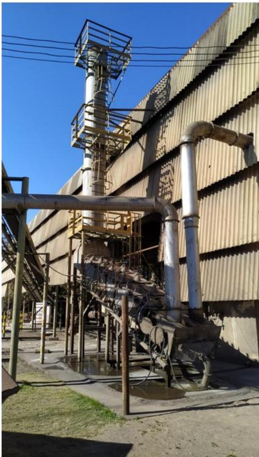
**Figura 5.** Sistema lavador de gases do tipo torre de spray, para a linha de granalhas.
