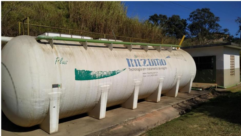
Figura 13. Estação de Tratamento de Esgotos sanitários.
