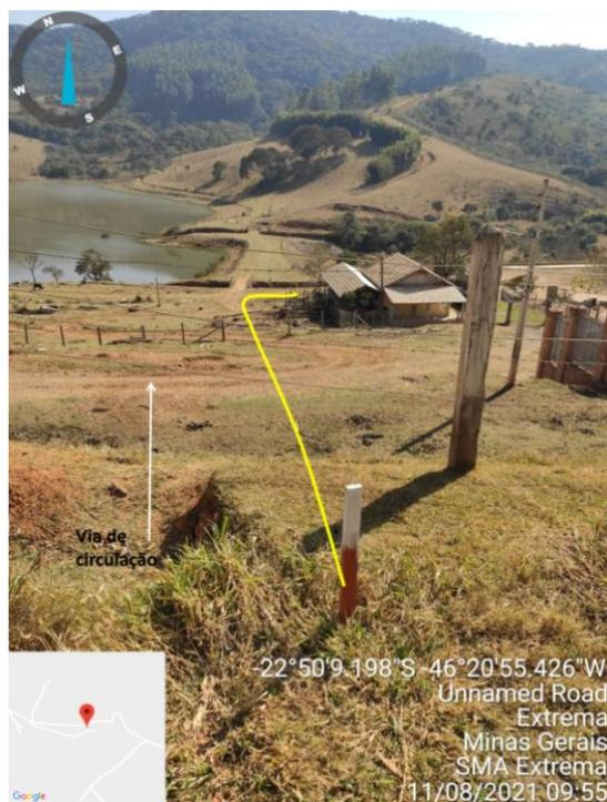
**Figura 7. Piqueteamento de delimitação do sistema viário a ser instalado no loteamento**
