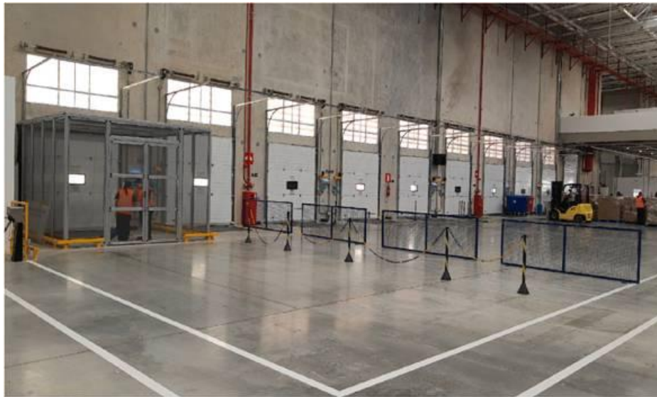
Figura 1. Vista interna das docas de recebimento e expedição – região Noroeste do galpão.
