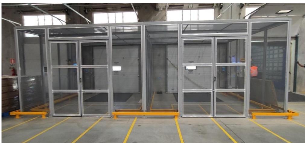
Figura 13. Docas de transferência de resíduos recicláveis para caçambas/contêineres.
