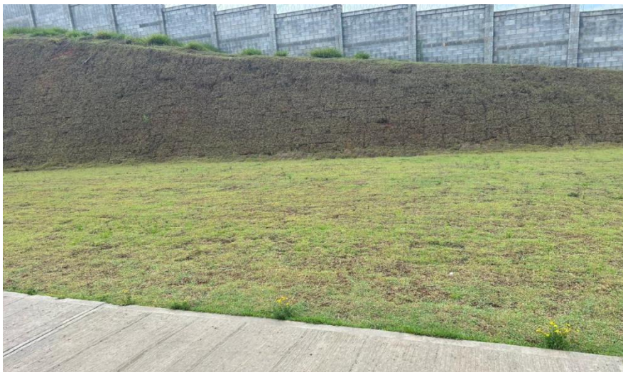
Figura 18. Registro apresentado nas informações complementares: Talude revegetado no entorno do galpão G400.
