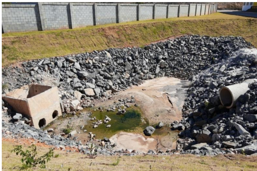
Figura 19. Caixa de contenção de águas pluviais que atende ao galpão G400.
