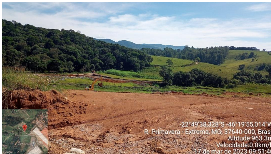
Figura 1. Vista da região Norte do terreno do empreendimento.
