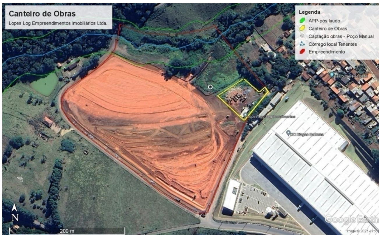
Figura 2. Localização do canteiro de obras do empreendimento (em amarelo). Google Earth Pro, jun/2023
