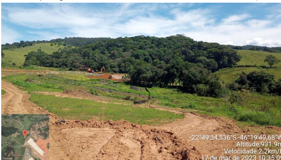
Figura 3. Vista da região Noroeste do terreno do empreendimento.
