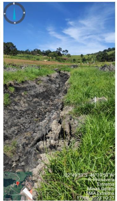
Figura 7. Execução de vala de drenagem/remoção de solo hidromórfico
