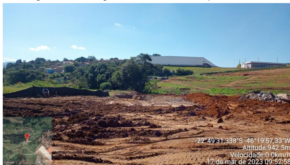
Figura 2. Vista da região Leste do terreno do empreendimento, com destaque para delimitação da APP, obras de terraplanagem e telhados das residências do Bairro dos Pedrosos (ao fundo).
