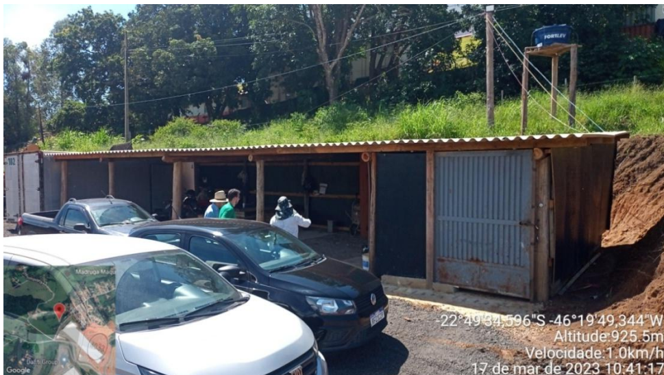
Figura 9. Canteiro de obras
