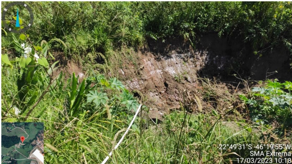
Figura 4. Processo erosivo das margens do córrego local
