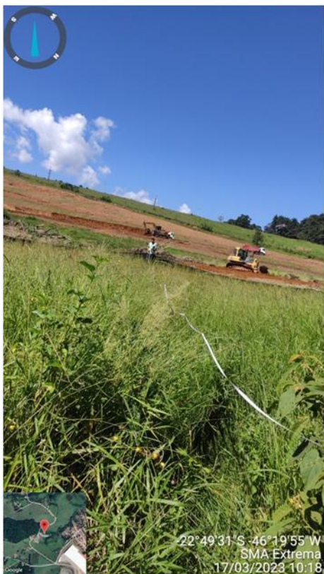
Figura 5. Verificação da faixa de 30 metros da APP do córrego local
