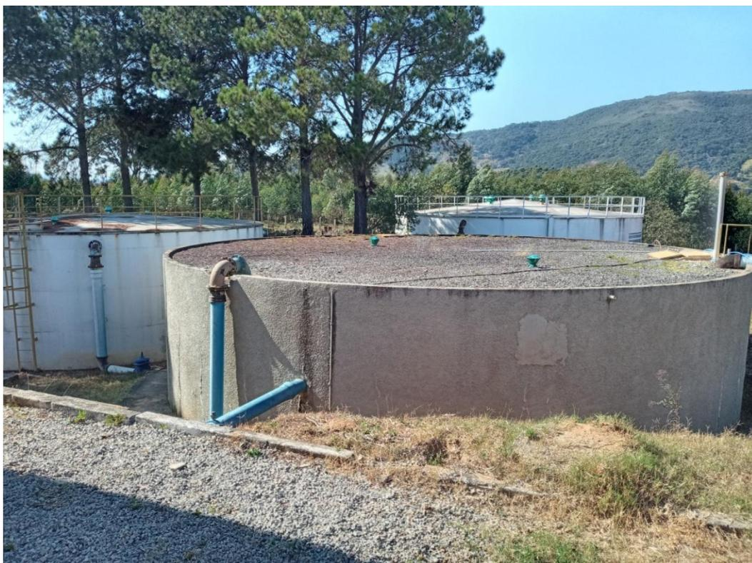
Figura 11. Tanques reservatórios de água tratada
