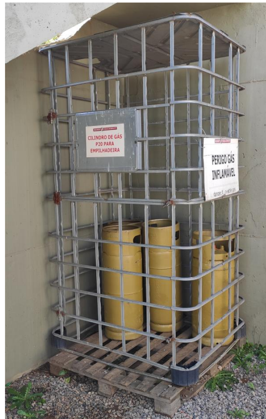
Figura 18. Local de armazenamento de GLP para empilhadeiras.
