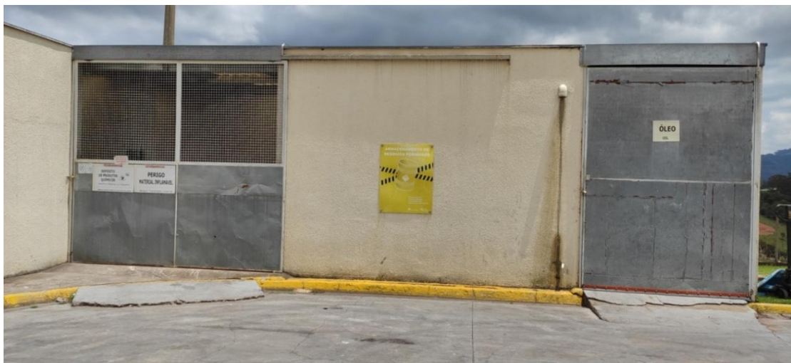
Figura 20. Local de armazenamento temporário de resíduos Classe I.
