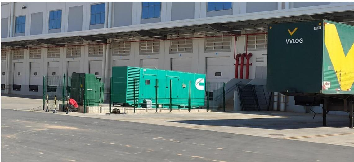
**Figura 14. Gerador de energia 2 (backup) do galpão**
