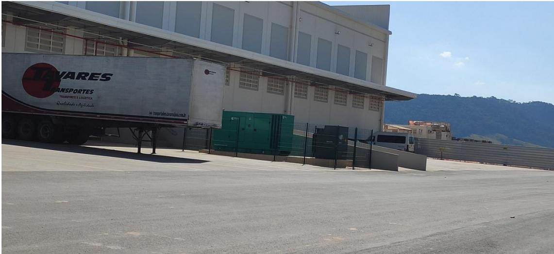
**Figura 13. Gerador de energia 1 (backup) do galpão**
