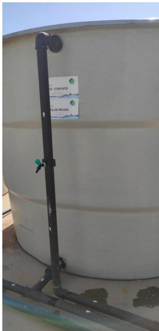
Figura 17. Primeiro tanque de reuso e ponto de coleta de amostra do efluente tratado
