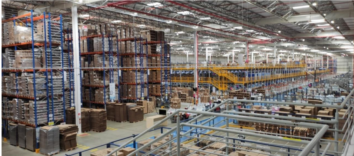
Figura 1. Vista interna da área de estocagem de produtos
