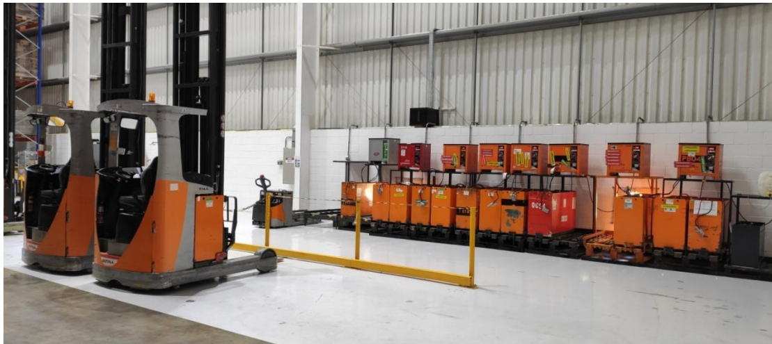
Figura 4. Área de recarga de baterias
