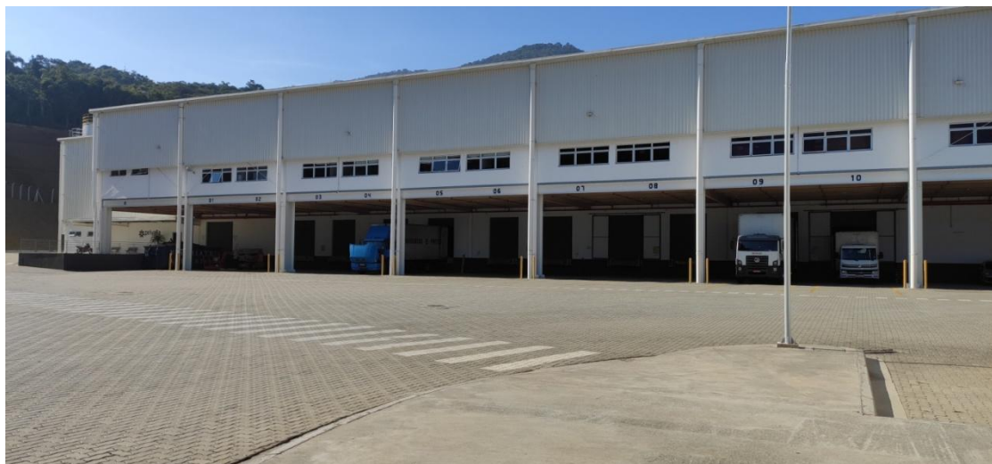
Figura 3. Vista externa das docas de recebimento e expedição
