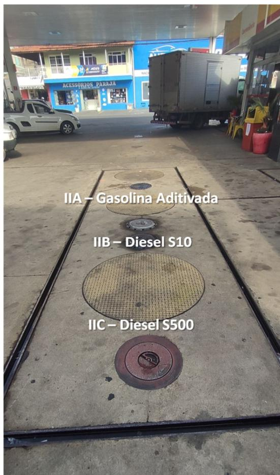
Figura 4. Vista das áreas de descargas direta e boca de visita do tanque IIA-IIB-IIC, com canaleta de contenção de vazamentos
