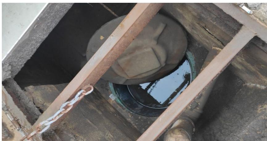
Figura 15. Sistema SAO lavagem - Entrada do efluente
