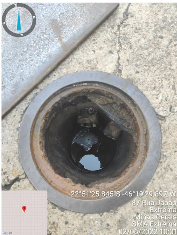
**Figura 19. Sistema SAO pista e tanques – Saída do efluente tratado para rede de esgotamento**
