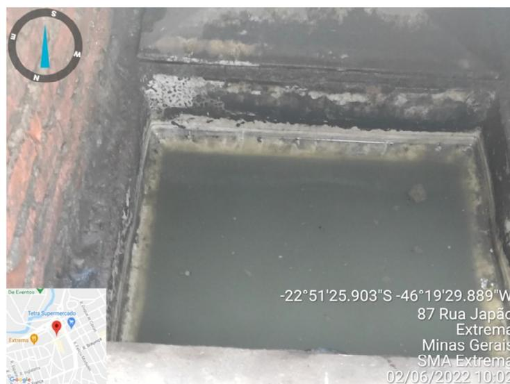
Figura 18. Sistema SAO pista e tanques – Separação
