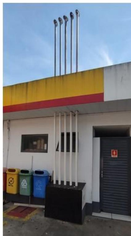
Figura 8. Tubulação de respiro dos tanques do SASC
