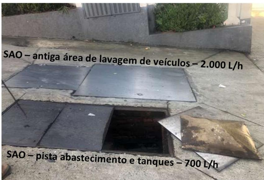
Figura 14. Sistemas Separadores de Água e Óleo
