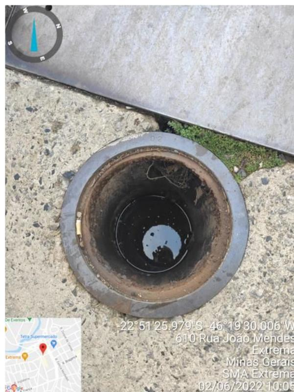
**Figura 20. Sistema SAO lavagem – Saída do efluente tratado para rede de esgotamento**
