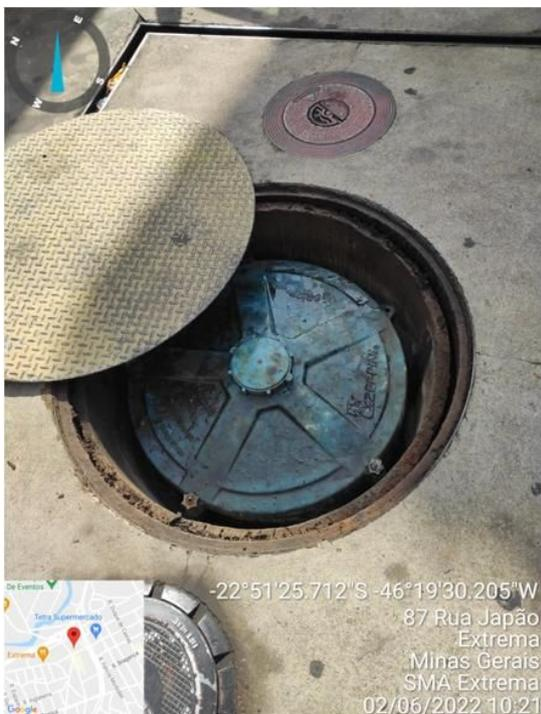
Figura 5. Boca de Visita e recarga do Tanque IIC – Diesel comum
