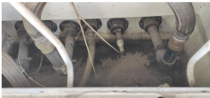
Figura 10. SUMP de uma das bombas de abastecimento
