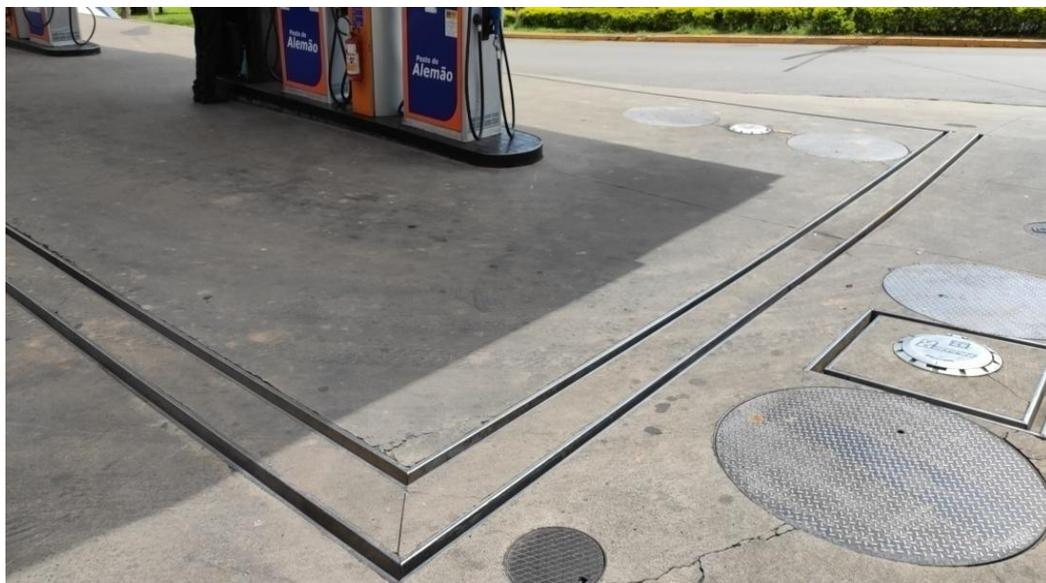
Figura 5. Canaletas de coleta e contenção ao redor da pista de abastecimento
