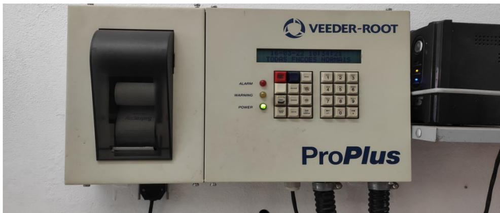
Figura 10. Equipamento de monitoramento intersticial dos tanques
