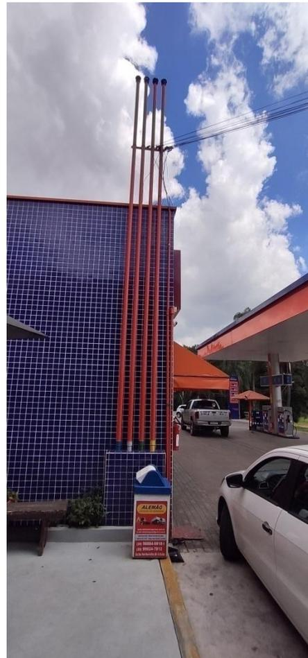
Figura 7. Tubulação de respiro dos tanques do SASC
