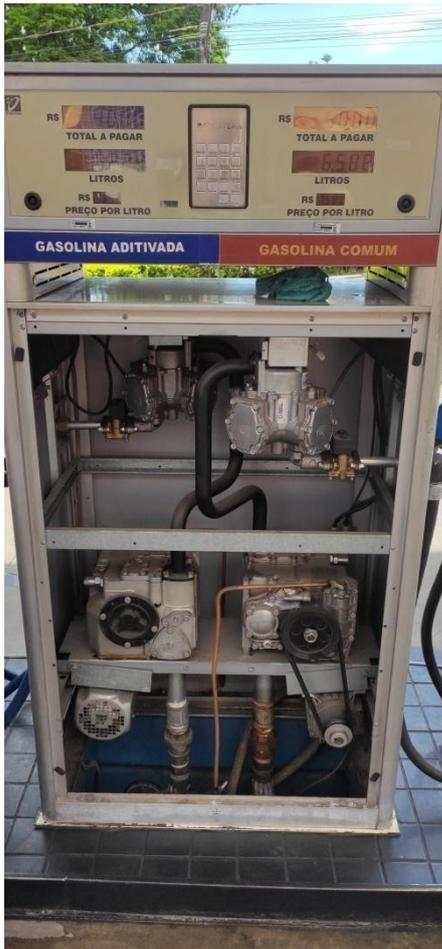
Figura 6. Uma das bombas de abastecimento, com destaque parcial para o SUMP de bomba (em azul)
