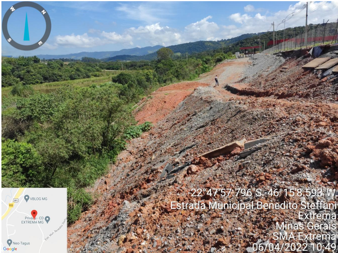
Figura 17. Vista geral da Estrada Municipal Benedito Steffani.
