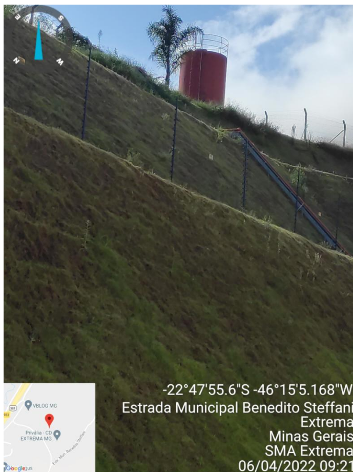
Figura 12. Caixa d'água do sistema de combate de incêndio.
