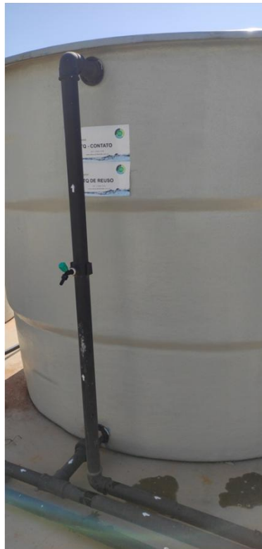
Figura 25. Primeiro tanque de reúso e Ponto de coleta de amostra do efluente tratado
