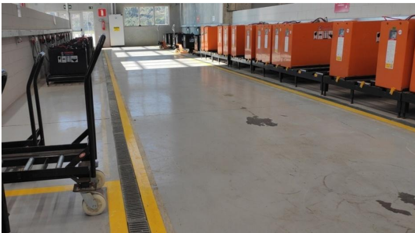
Figura 20. Destaque para as canaletas de contenção da área de recarga de baterias e direcionamento para tanque de contenção
