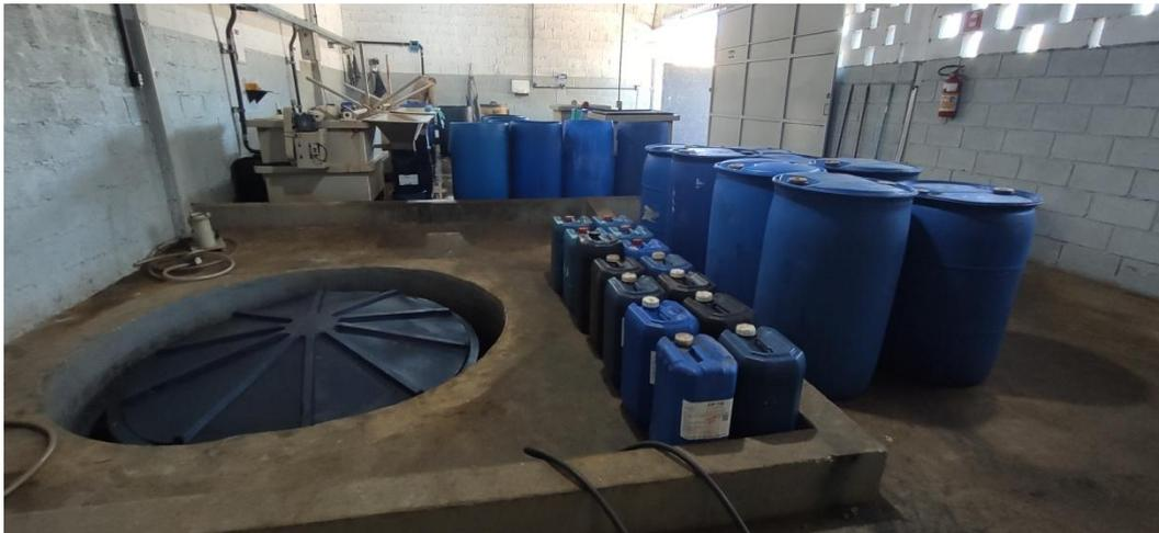
**Figura 14. Tanque reservatório de Resíduos Classe I e local de armazenamento de insumos em área impermeável e com sistema de contenção.**
