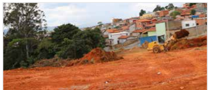
Terraplanagem CEIM da Vila Esperança
