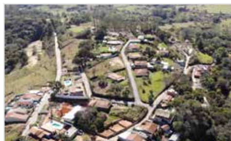
Complementação de pavimentação asfáltica no Jardim dos Ipês.
