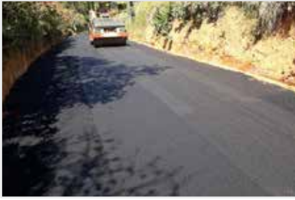
Asfaltamento Chacreamento Santa Rita
