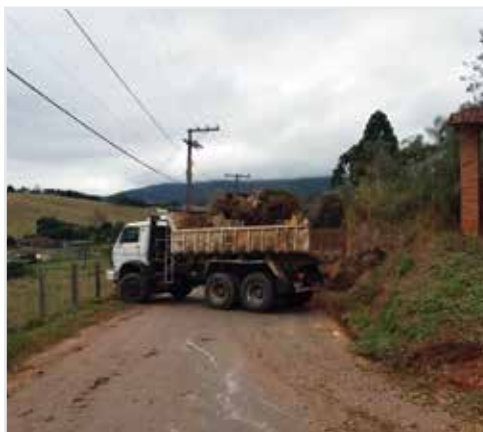
Manutenção de estradas rurais
