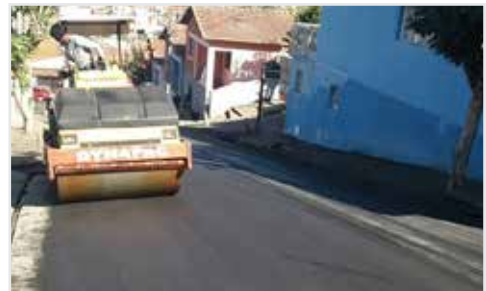
Asfaltamento em ruas do Centro
