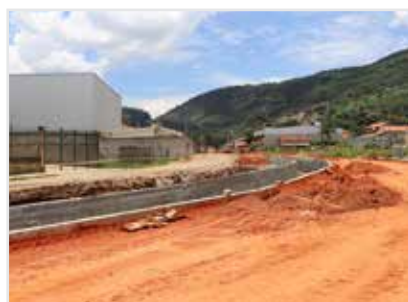
Av. José Marques de Oliveira Neto, novo acesso ao Bairro Vila Rica
