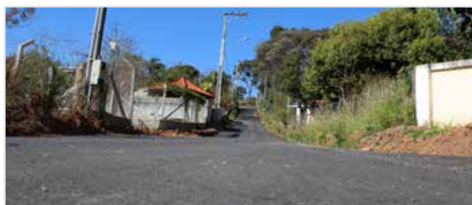
Asfaltamento no Loteamento Céu da Mantiqueira – Bairro do Godoi
