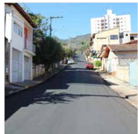
Asfalto novo na Rua Padre Carbone
