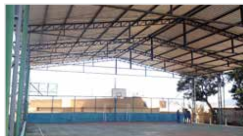
Cobertura da quadra da Mantiqueira
