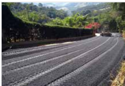
Asfalto no Bairro das Furnas (1.250 metros)
