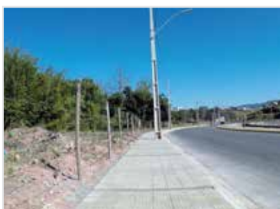
Calçada na Avenida Lavapés
