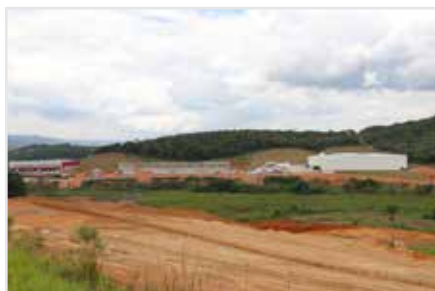
Ampliação do Distrito Industrial dos Pessegueiros.
