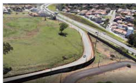
Alargamento no Acesso ao Bairro do Godoi/ Cachoeira 3 com implantação de iluminação.
