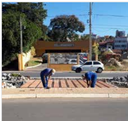
Ponte sobre córrego da Av. Lavapés: nova ponte para pedestres em frente à UBS do Bairro
