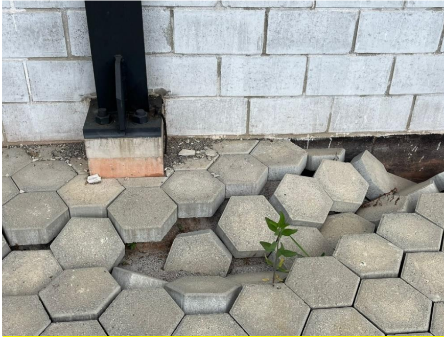
Figura: Piso intertravado ao lado do galpão. Fonte: Autor, agosto/2023.
